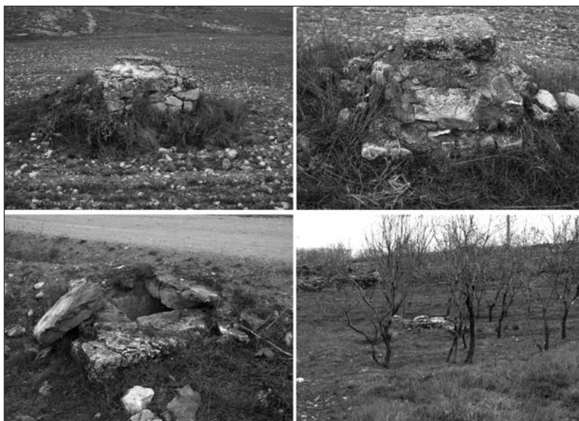
Figura 4. Registros de la captación del acueducto de Segobriga en el año 2002. Arriba, a izquierda, registro n° 7; a la derecha, registro n° 6, los dos cerrados con ayuda de cemento en época moderna. Abajo a la izquierda, registro n° 1 casi cubierto por un camino actual y con la tapa fracturada. Abajo a la derecha, registro n° 4 en un canal secundario de la captación. Fotografías de J. M. Abascal, de febrero de 2002.
