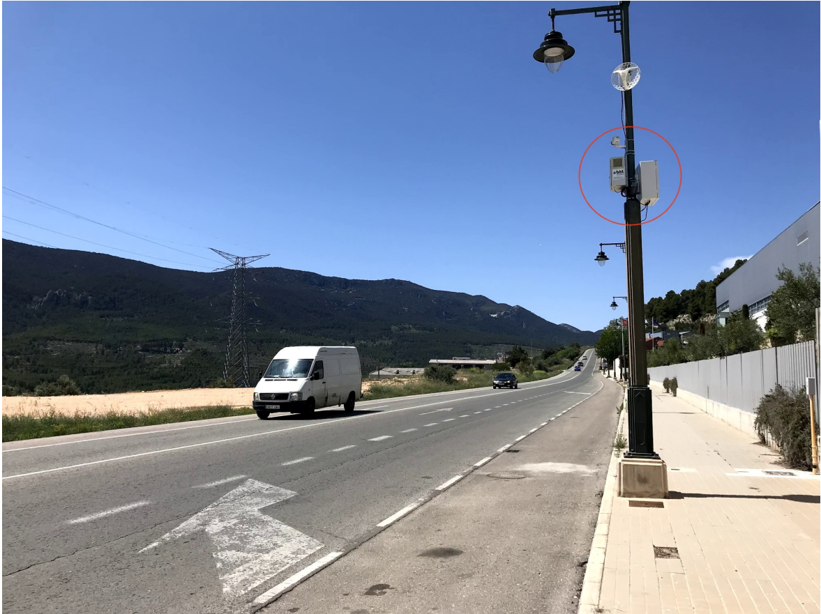
Figura 5: Cámara Acceso Batoi
