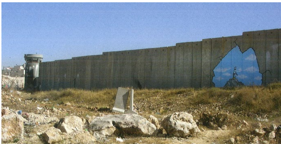
Detalle de la torre de control próxima al grafiti de Banksy - Fuente: Banksy 2006: 140
