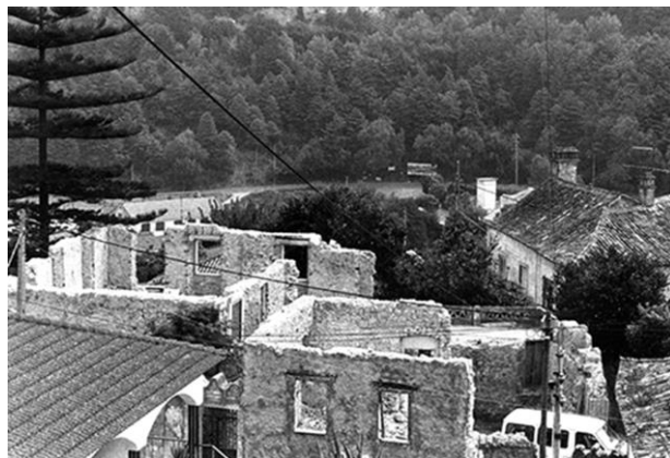
Fig. 1. Vivienda de Alenquer tras el derrumbe, Aires Mateus, 1999.
