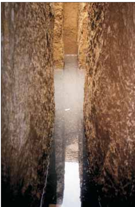
Figura 13. La caja de giro de la noria vista desde el interior de la galería.
