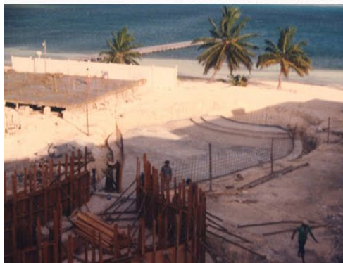
Construcción Hotel Royal Resorts, 1977
