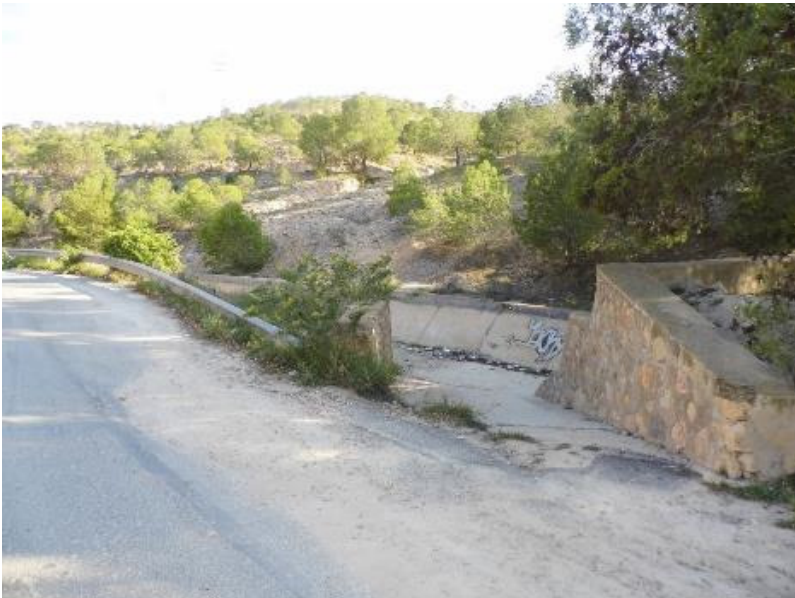
Foto 4. Rampa de acceso al canal desde el vial paralelo al mismo.
