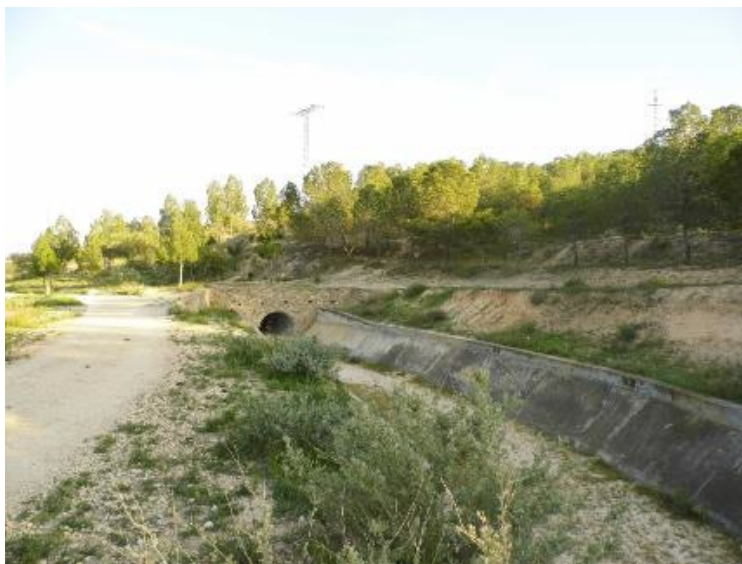
Foto 3. Tramo final del canal de 1992 e inicio del tramo soterrado que conecta con el canal construido en 1991.
