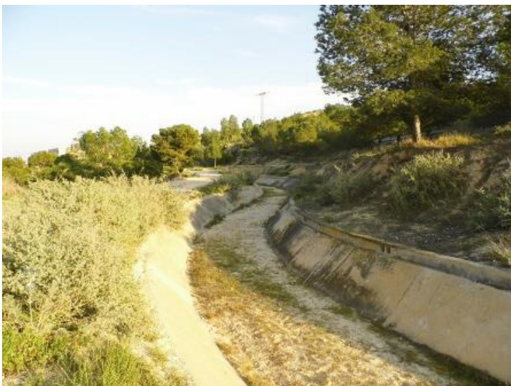
Foto 2. Tramo del canal construido en 1992 (2ª fase).
