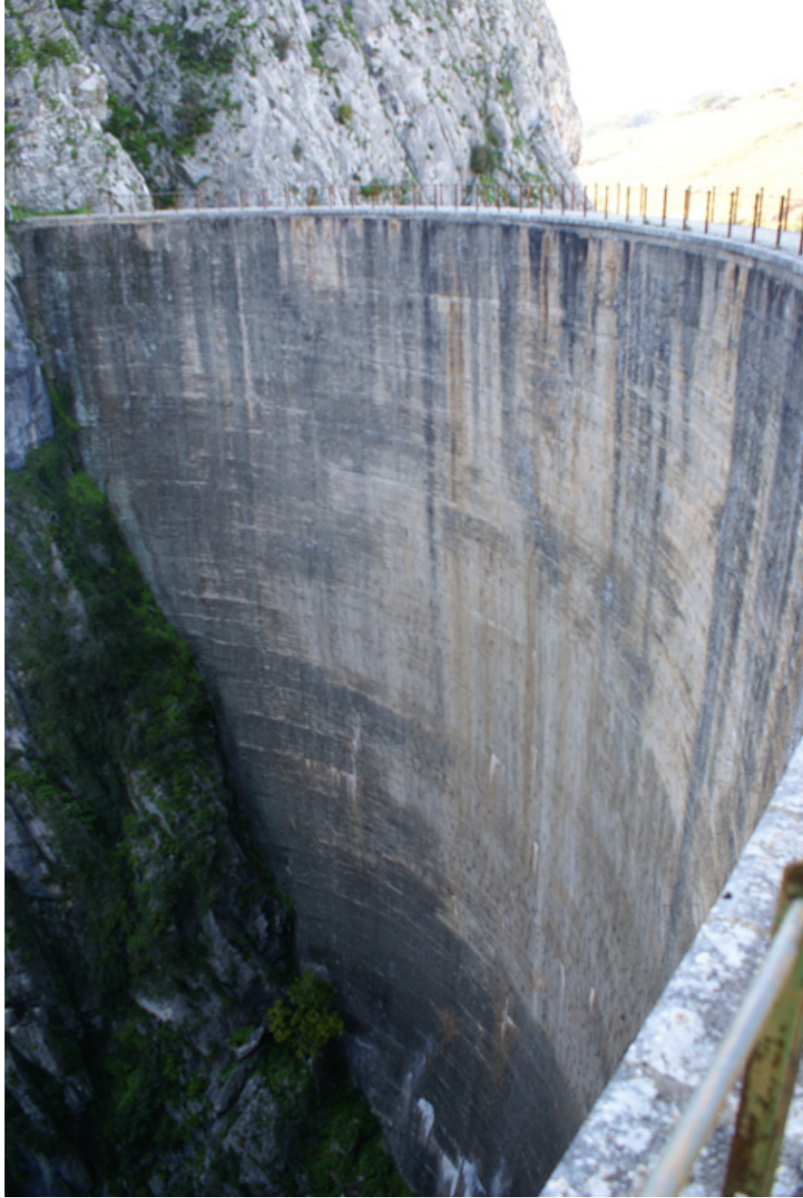
Figura 15.- Presa de Montejaque.
