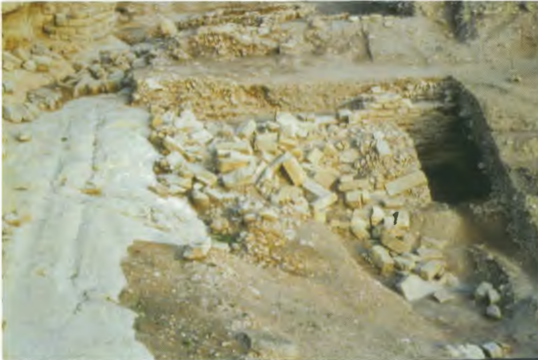
Fig. 72. Derrumbe del baluarte sobre el camino de acceso y la vaguada del Reguerón
