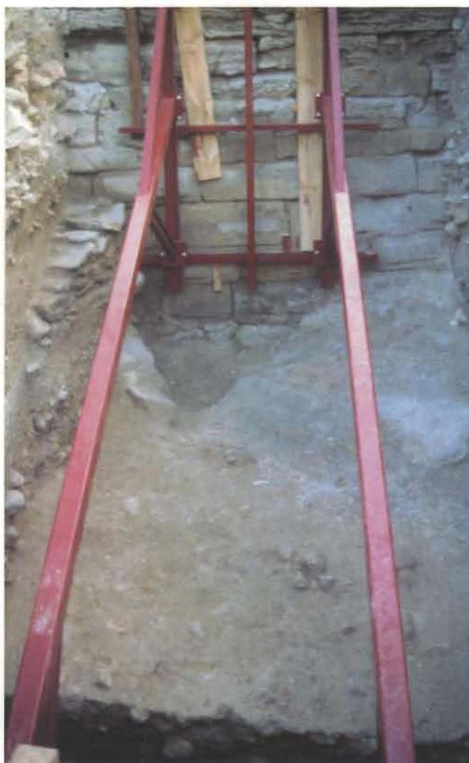
Fig. 31. Estructura de contención del baluarte.
