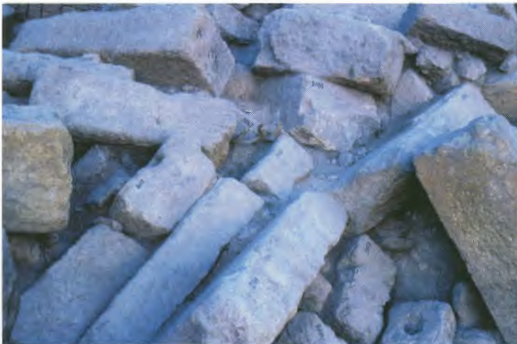
Fig. 73. Derrumbe de sillares. Vista parcial.
