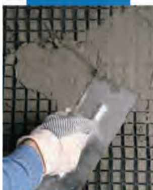
Colocación de Mapegrid G 220
