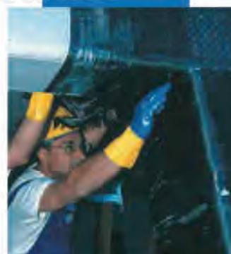
Fajado de un encuentro viga-pilar
