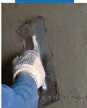
Cubrimiento de Mapegrid G 220 con la última capa de Planitop HDM
