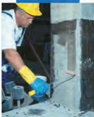
Aplicación de MapeWrap Primer 1
