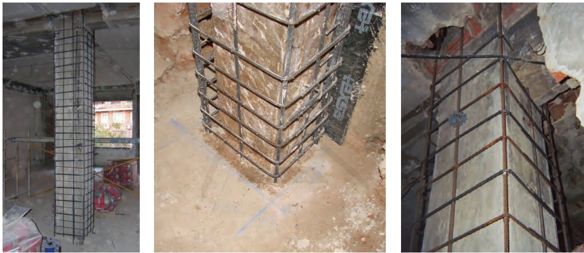
Figura 2.24. Ejemplos de ejecución de encamisados de hormigón.
