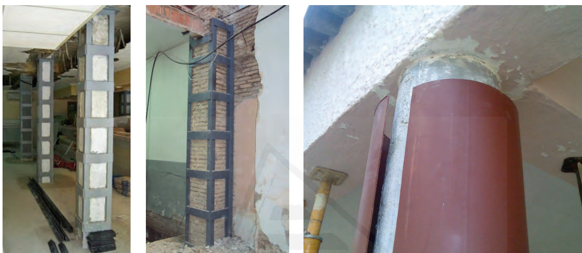
Figura 2.23. Ejemplos de soportes reforzados con perfiles y chapas de acero.
