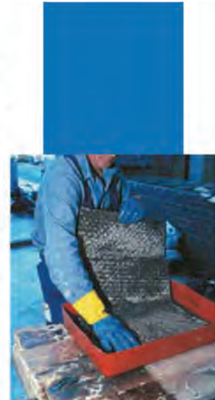
Impregnación manual de MapeWrap C
