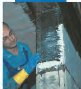
Fajado de pilares y vigas
