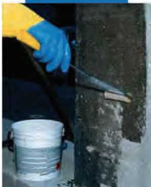
Extensión de MapeWrap 31 con rodillo, sobre una capa de MapeWrap 11 (o MapeWrap 12) aún fresca
