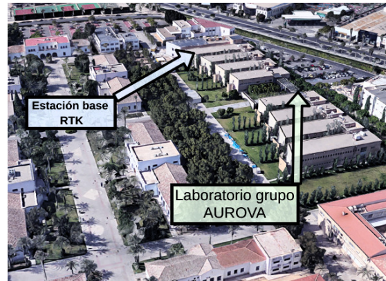
Figura 2: Vista aérea de nuestra zona de trabajo. En esta imagen podemos ver la situación del laboratorio principal del grupo AUROVA, así como el punto escogido para ubicar la estación base.
