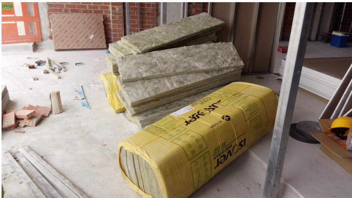
Fig. 9.7 – Acopio de material.
