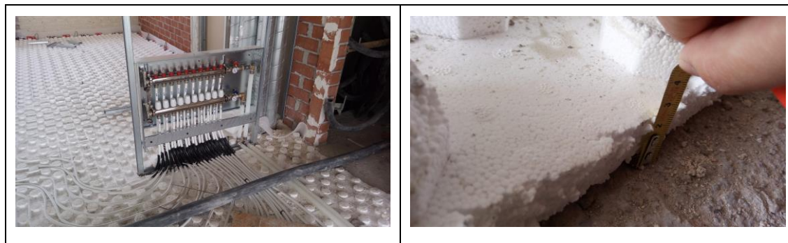
Fig. 9.16 – Suelo Radiante.
