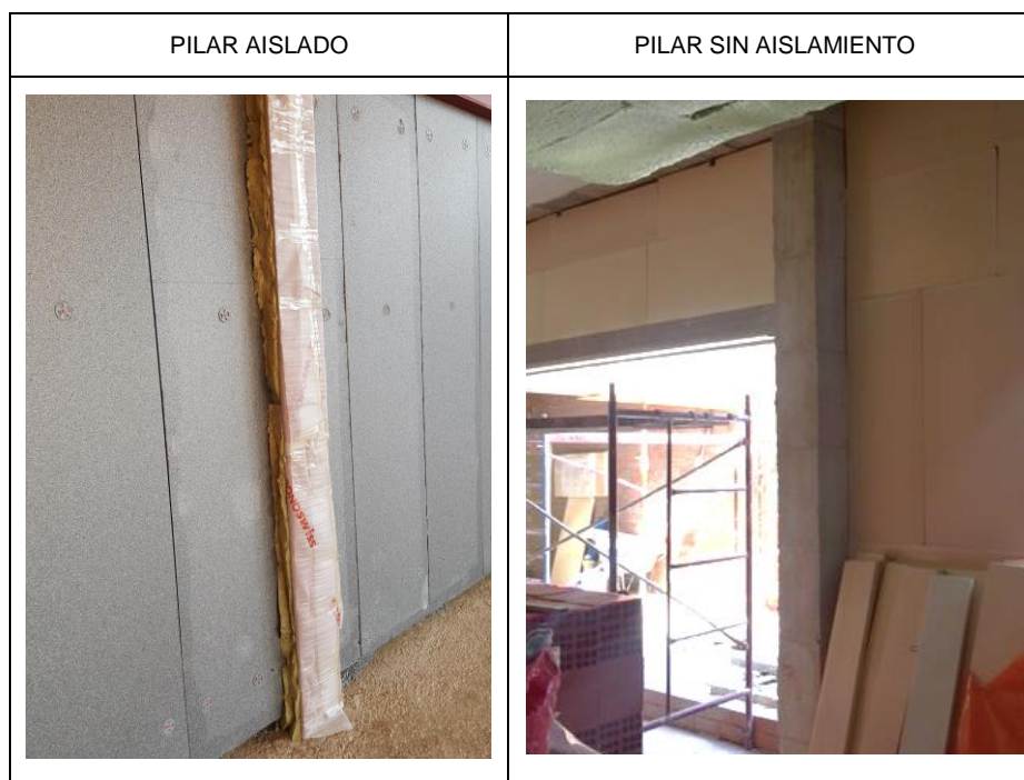
Fig. 9.18 – PT: aislamiento pilares.
