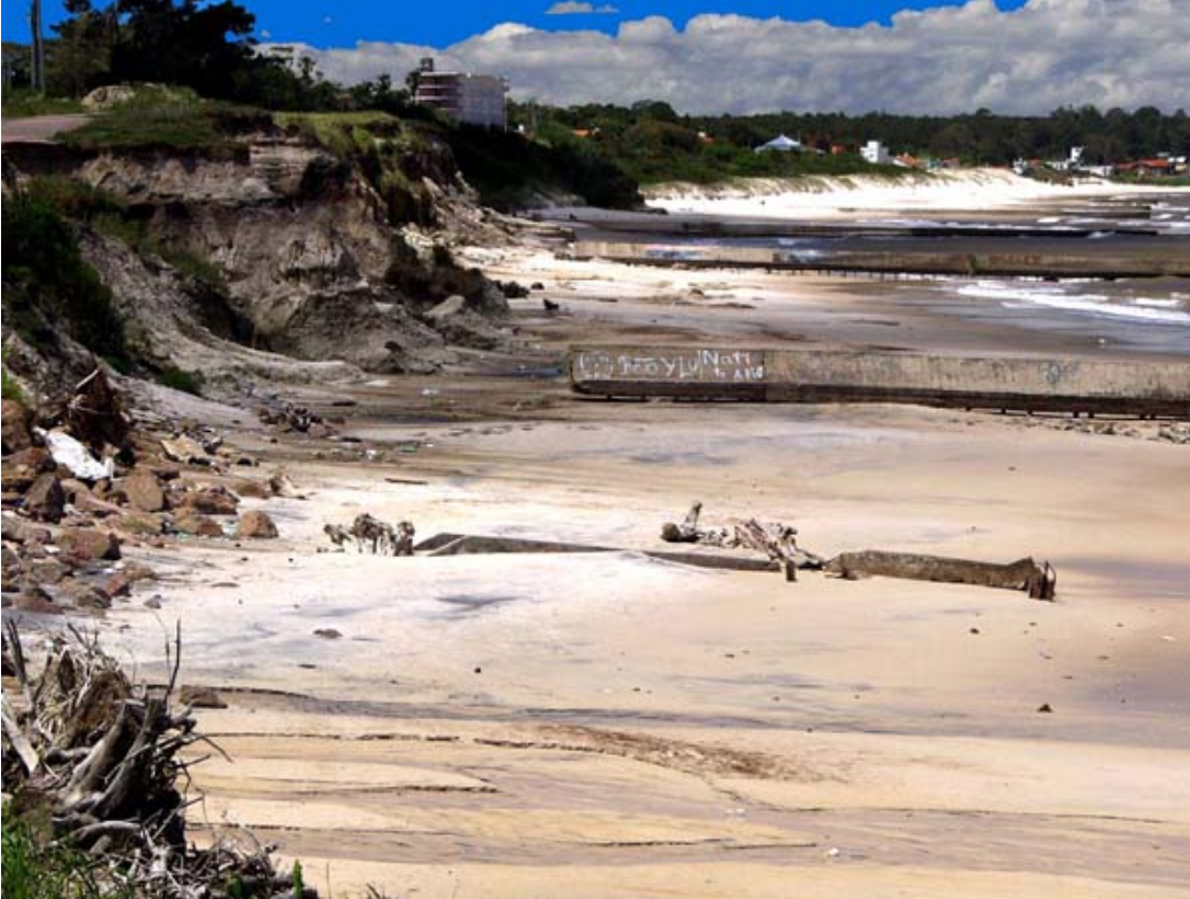
Figura 2. En el Balneario Las Vegas (cercano a Montevideo), se ejemplifica como eliminado el cordón dunar por efecto indirecto de la forestación, se produce el retroceso de la línea de costa, el cual intentó ser paliado con la construcción de espigones, que agravaron el proceso. Por detrás, la costanera comienza a desmoronarse. (Fotografía: Dr. Augusto Pérez Alberti).
