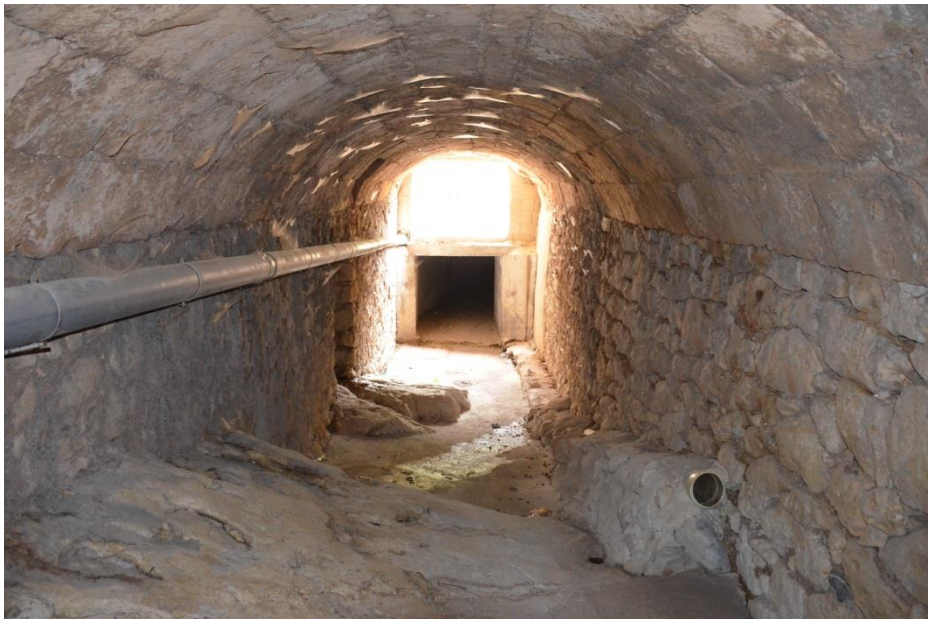
Fot. 40. Vista hacia aguas abajo de la bóveda de cañón. Autora: Núria Ginestar (17/03/2018).
