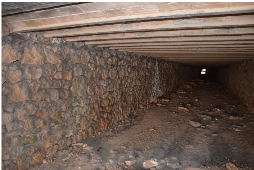
Fot. 7. Inicio del Sector I, vista subterránea. Autora: Núria Ginestar (10/12/2017).
