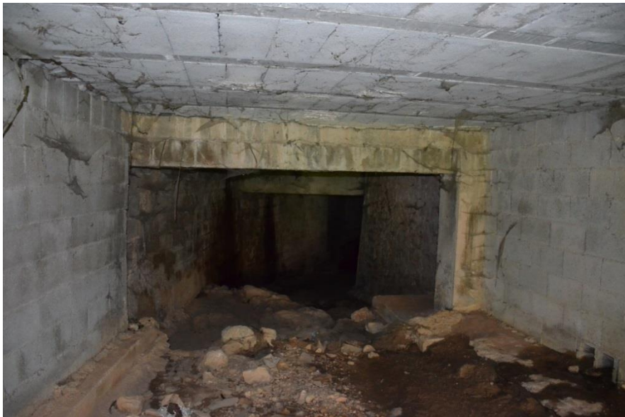
Fot. 18. Vista aguas abajo del Tramo 1 (Sector III). Autora: Núria Ginestar (17/03/2018).
