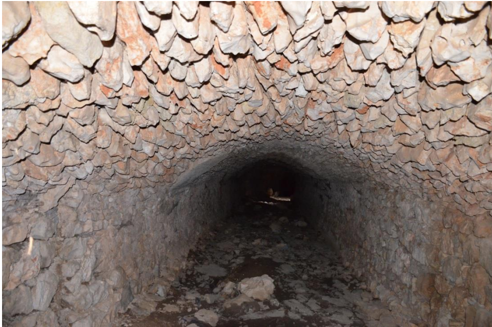
Fot. 28 Bóveda asentada sobre muros de piedra caliza. Autora: Núria Ginestar (17/03/2018).
