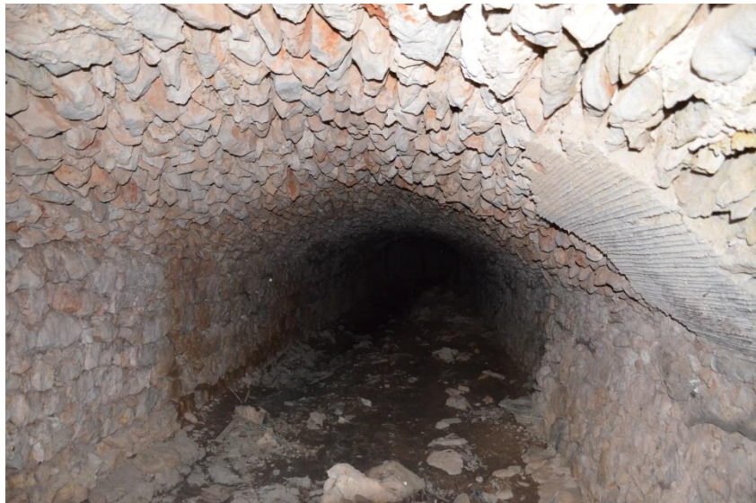
Fot. 33. Restos del encofrado (margen dcha. de la imagen) que cubrirían toda la bóveda. Autora: Núria Ginestar (17/03/2018).
