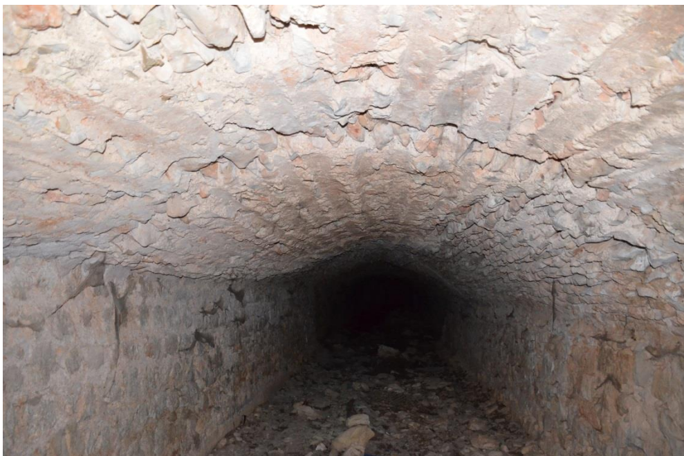
Fot. 30. Parte final de la bóveda. Las piedras permanecen, todavía, recubiertas. Autora: Núria Ginestar (17/03/2018).
