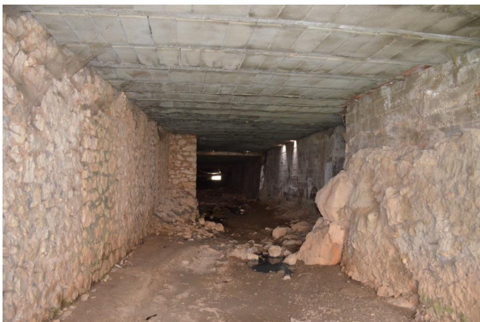
Fot. 15. Vista aguas arriba de la canalización (muro de piedra a la izq. y bloque de hormigón a la dcha.). Autora: Núria Ginestar (17/03/2018).
