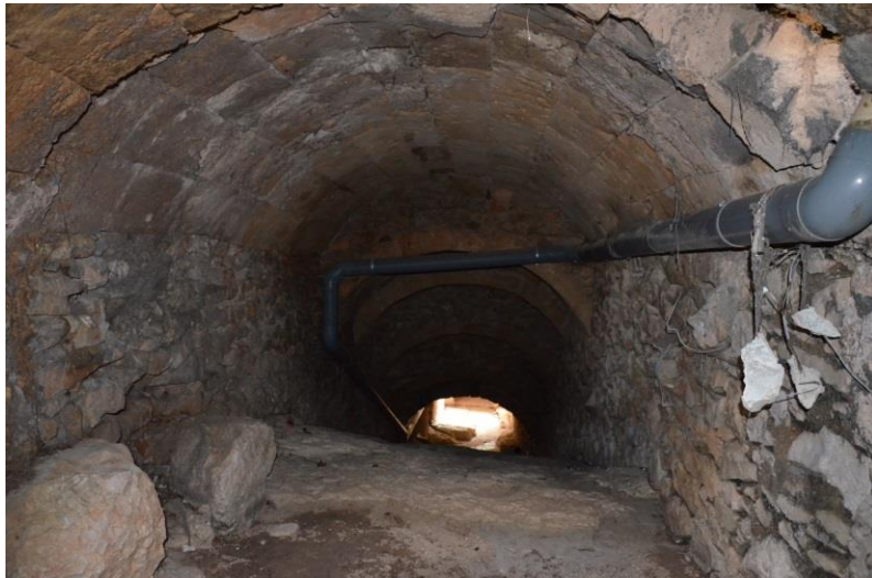
Fot. 37. Bóveda bajo la vivienda de la Fot. 36. Autora: Núria Ginestar (17/03/2018).
