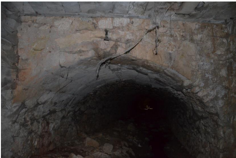
Fot. 27 y Figura 29. Arco de medio punto, formado con piedras de tosca. Autores: Núria Ginestar (17/03/2018) y Ángel Blasco (figura).
