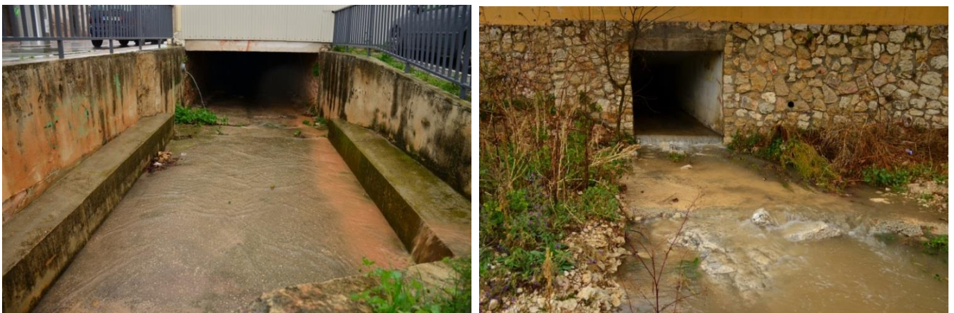
Fots. 49 y 50. Entrada de aguas de escorrentía a la canalización subterránea (izq.), el día 2 de febrero de 2018, y avenamiento de las mismas al río Gorgos, en su tramo final (dcha). Autora: Núria Ginestar (02/02/2018).
