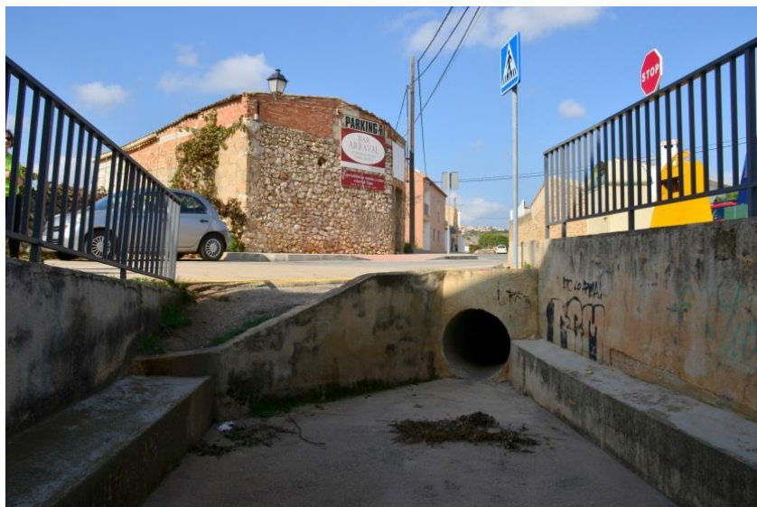
Fot. 6. Vista aguas arriba del cauce. Conducto que vierte las aguas pluviales al barranco. Autora: Núria Ginestar (10/12/2017).
