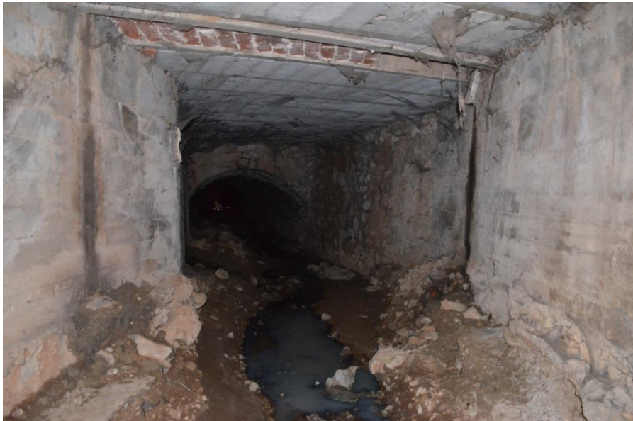
Fot. 26. Final del Tramo 3. Autora: Núria Ginestar (17/03/2018).
