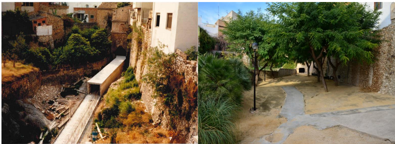
Fots. 43 y 44. Construcción de la Galería Visible del barranco (izq.). Fuente: Archivo Municipal de Gata de Gorgos. Y situación actual (dcha.). Autora: Núria Ginestar (17/03/2018).
