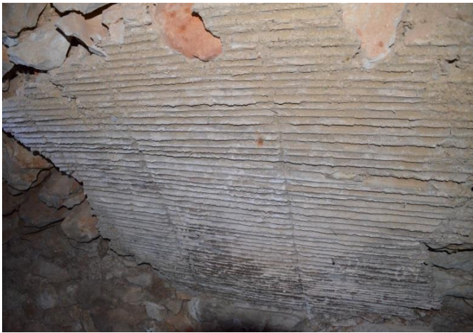
Fots. 31 y 32. Porción del material del encofrado que aún perdura (izq.) y estructura actual del cañizo (dcha.). Autores: Núria Ginestar (17/03/2018) y José Ginestar (26/10/2014).
