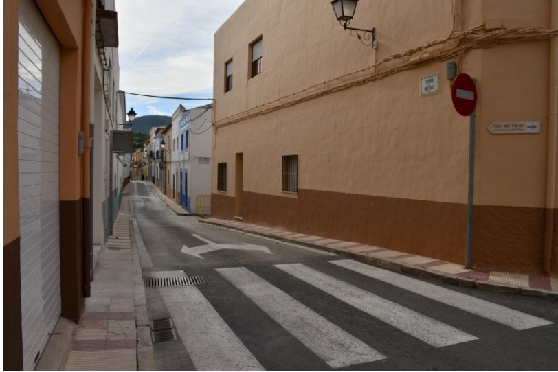
Fot. 10. Tramo de la calle Bissertot, que cubre actualmente el puente. Autora: Núria Ginestar (17/03/2018).
