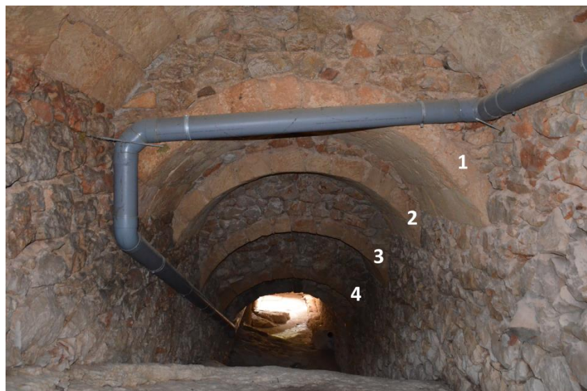
Fot. 38. Vista hacia aguas abajo de los arcos dispuestos de forma escalonada, acorde con la inclinación del suelo. Autora: Núria Ginestar (17/03/2018).
