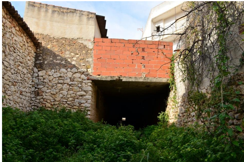
Fot. 17. Vista hacia aguas arriba del Sector II. Autora: Núria Ginestar (17/03/2018).
