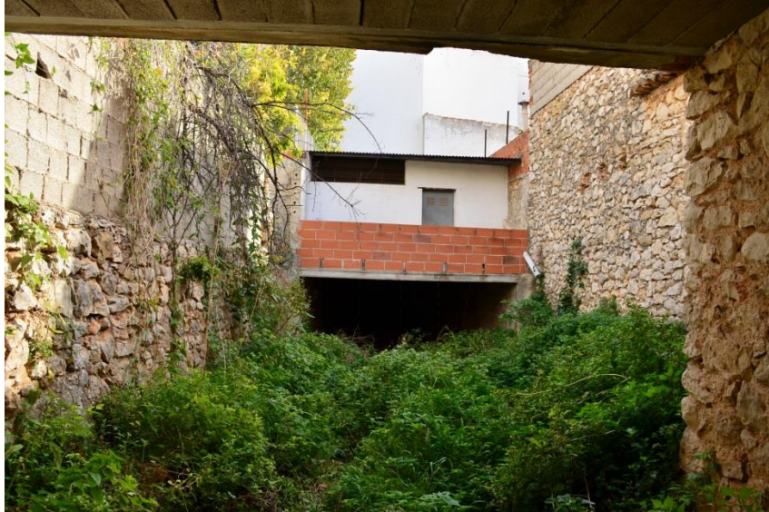
Fot. 16. Vista hacia aguas abajo del Sector II. Autora: Núria Ginestar (17/03/2018).
