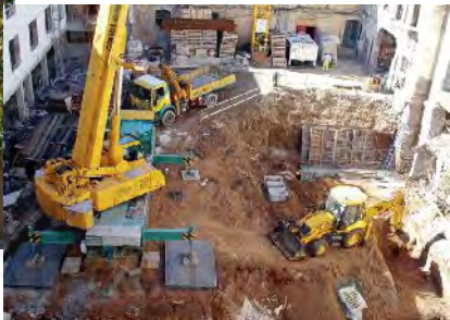
Fig. 3.2-5 Hospital Marina. Granada
