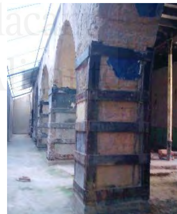
Fig. 15.4.2.2-2 Arquerías de la Casa de la Pólvora (Elaboración propia)
