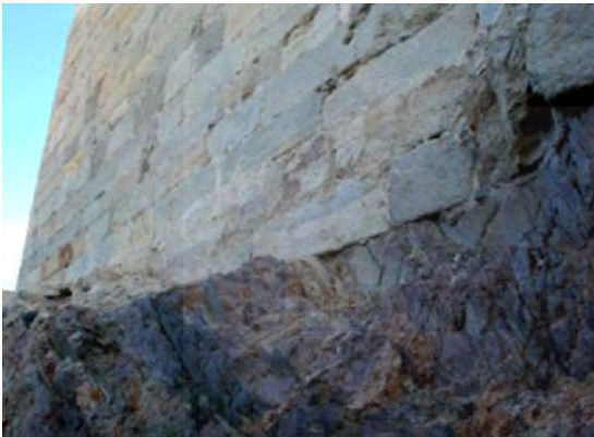
Fig. 14.5-3 Asiento de la torre directamente sobre la roca del monte.
