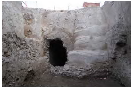
Fig. 15.4.1-5 Torre sureste del recinto superior; flanco norte (agosto, 2009). Obsérvese las cuatro rezarpas
