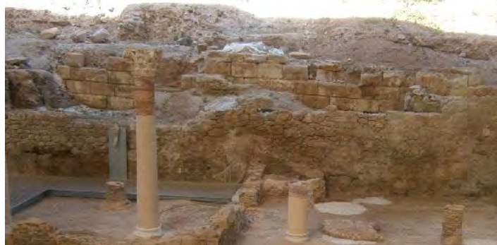
Fig. 18.2-15 Muro de contención en barrio del foro, donde se apoya la calzada del nivel superior
