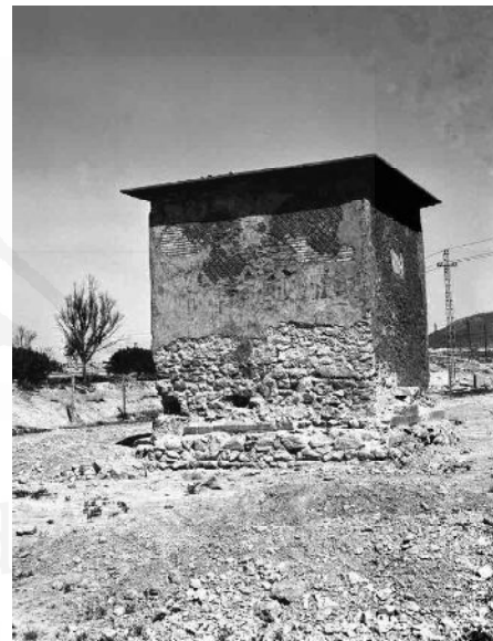
Fig. 11.10.1-3 Estado de la Torre Ciega previo a la restauración de P. San Martín Moro (1967), tras eliminar la verja levantada en la intervención de A. Beltrán (años 40) (D-DAI-MAD.WIT-R-123-67-04).
