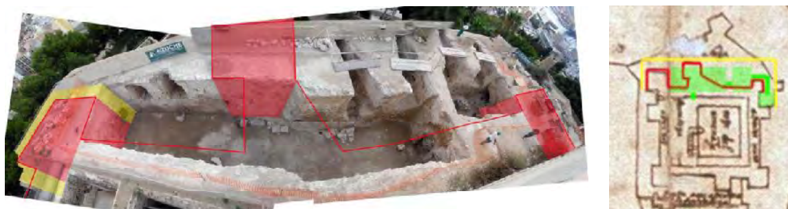
Fig. 13.3.1.4-1 A la izquierda excavación de las bóvedas del frente situado a levante (agosto, 2009); en rojo: torres y aproximación a la línea del recinto superior; en amarillo: recerido de la torre noreste. A la derecha localización del área excavada sobre el plano el plano del corregidor Dávalos (1541; AGS/MPD-XIX-167); en rojo frente este, y en amarillo posterior alineación para la construcción de las bóvedas realizadas en el siglos XVII (Munuera Navarro, 2010)
