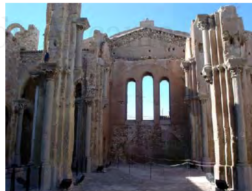
Fig. 14.7.1-7 Estado actual nave central de la iglesia Mayor de Cartagena.
