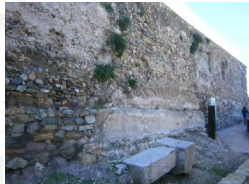
Fig. 15.4.1-8 Frente este del muro que cierra las bóvedas del Castillo (Elaboración propia), donde podemos observar el antiguo lienzo de la torre y los recrecidos laterales para alinear la muralla.
