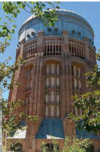
Fig. 3.2-2 Depósito elevado del Canal de Isabel II. Madrid
