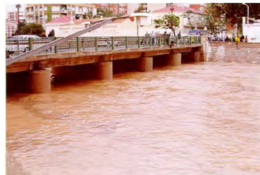
Fig. 5.2.1-5 Puente Barrio de la Concepción año 2000
