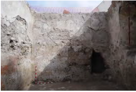
Fig. 15.4.1-4 Torre noreste del recinto superior; flanco sur (agosto, 2009). Obsérvese el regresamiento del frente del torreón a la derecha
