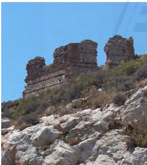
Fig. 15.2.3-7 Ruinas de la torre de Navidad en la actualidad. (Fuente propia)
