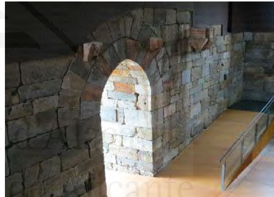
Fig. 14.5-4 Puerta de acceso a la torre del homenaje.
