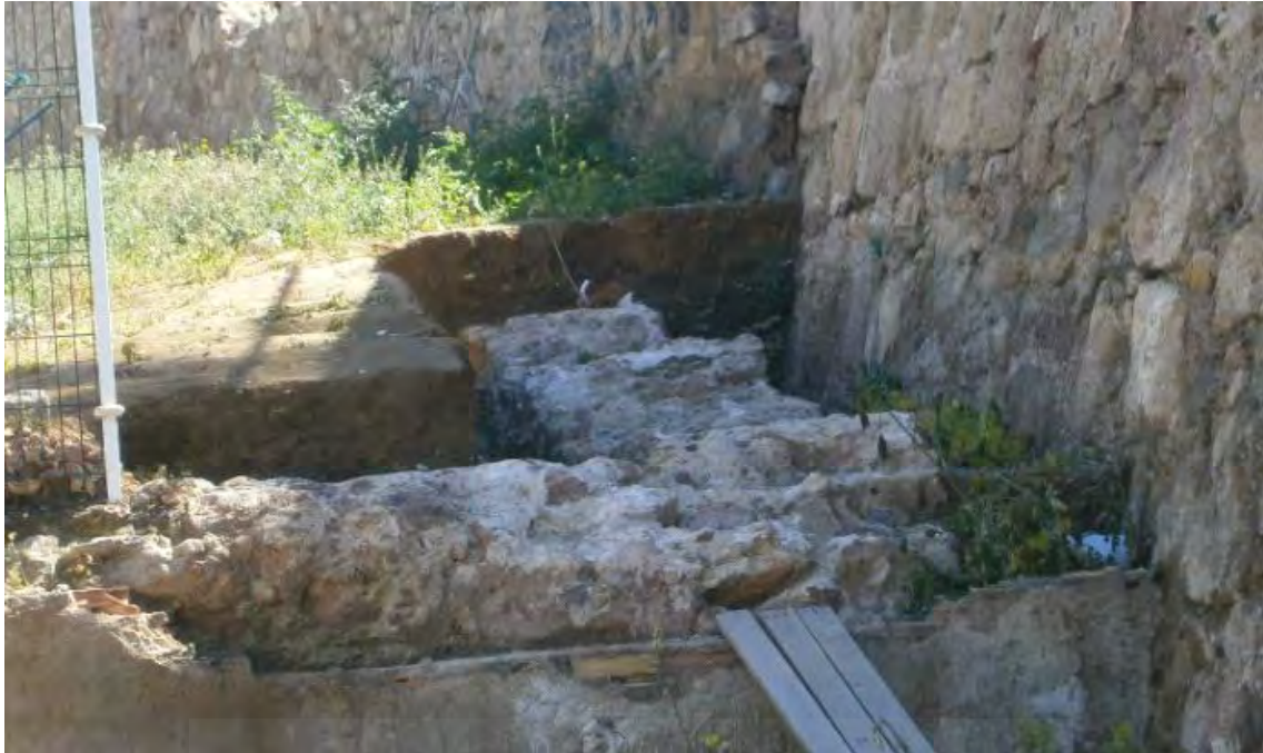
Fig. 11.3.1-3 Tramo de la muralla romana junto al cabezo de la Serreta
