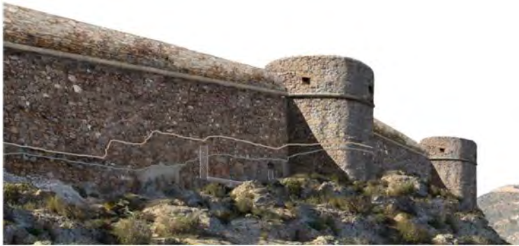
Fig. 15.2-3 Reproducción de la muralla del Deán. Las cortinas se construyeron con cimentaciones corridas y escalonadas de argamasa, el zócalo de mampostería y los alzados de tapial recubiertos con mortero. Los cubos artilleros están contruidos con tapia de hormigón y mampostería. ( http://www.um.es/molinete/?page_id=261 )
