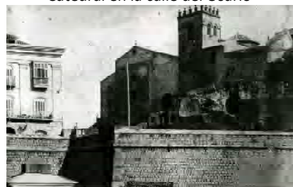
Fig. 14.7.1-3 Detalle de la vista exterior de las Puertas del Muelle al comenzar su demolición y la Iglesia Catedral antes de su rehabilitación
