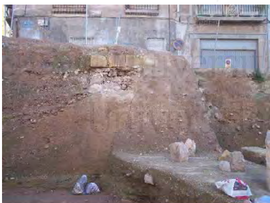
Fig. 15.2-7 Calle del Adarve (Molinete), donde se puede apreciar los sillares hincados, así como el talud recrecido en lo que se puede interpretar como una reparación. (Munuera Navarro, 2010)
