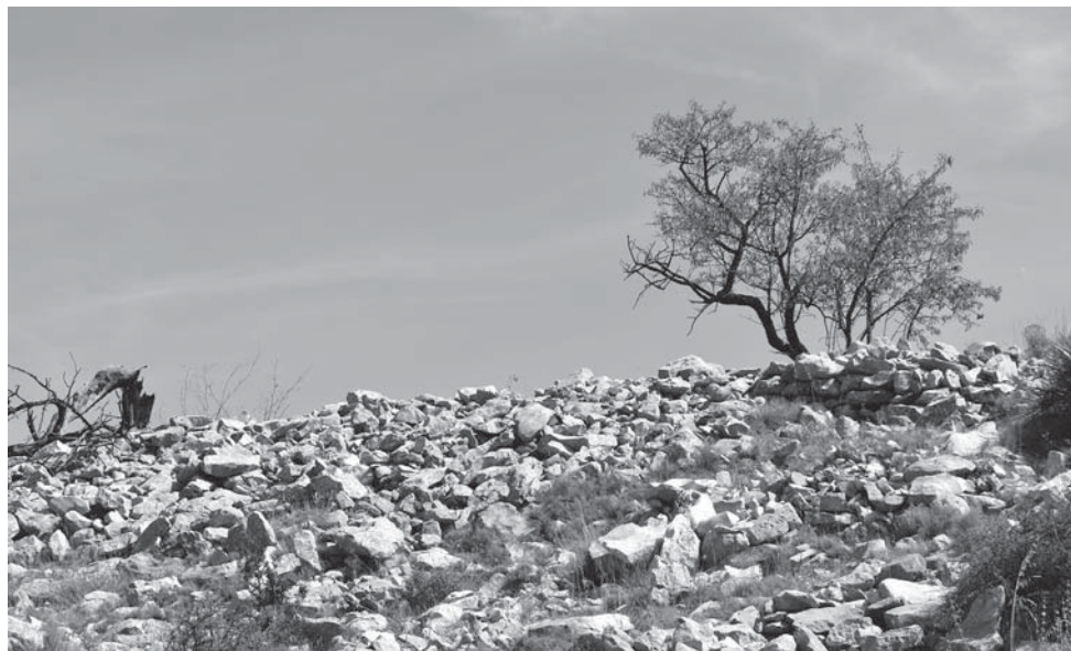
Penya de Pere Martí. Aspecto del muro medieval.
