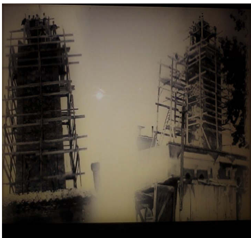
Construcción de la mezquita
