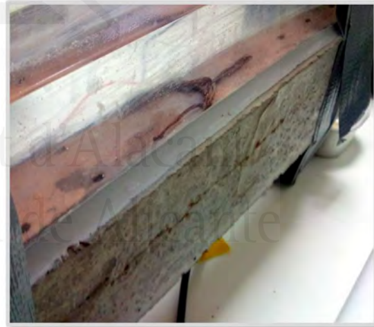
Figura 2. 22: Imagen de la fisura longitudinal originada.
