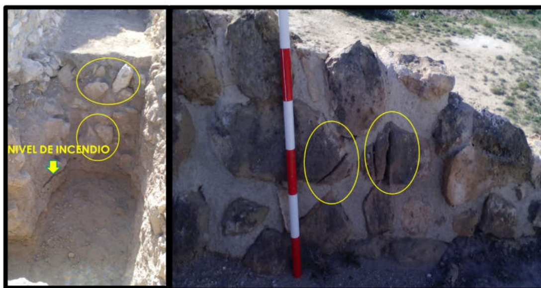
Fig. 5- a) Imagen Izda.: Bloques caídos desde la parte superior de la muralla; Imagen Dcha.: sillares de piedra que han cedido ante un efecto compresión/descompresión.
