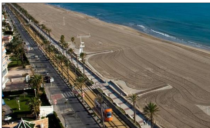
Figura 8. Vista aérea de la Playa de Muchavista (Campello), donde se observan las vías del tranvía separadas de la zona de playa.
