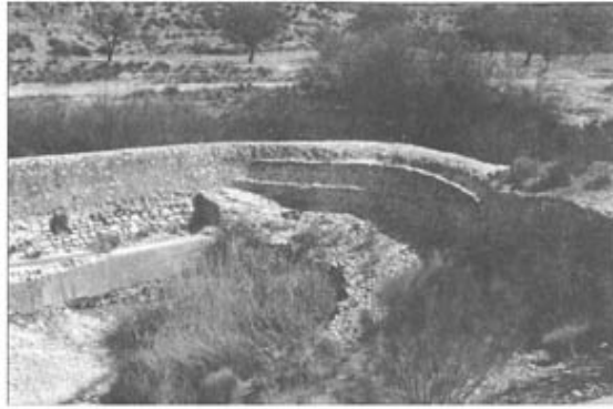
FOTO 1. Paramento de aguas abajo de la presa de Román. De derecha a izquierda de la imagen se observa: estribo; presa en arco, a cuyo pie se sitúa el talud-vertedero; tramo recto de la presa; cimbra y canal de aguas permanentes.
