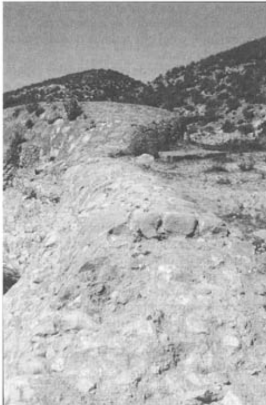
FOTO 3. Aliviadero (en primer término) y partidor de aguas (en segundo plano). Obsérvese la sólida construcción de ambas obras de fábrica.
