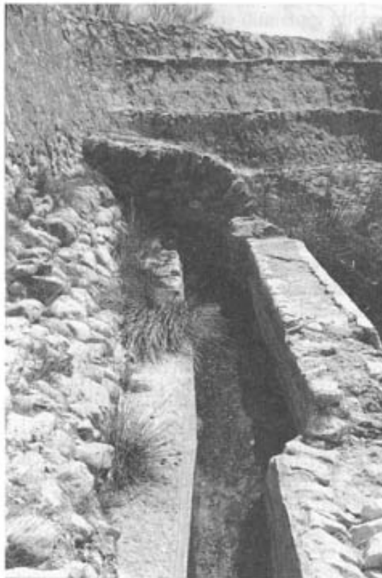
FOTO 2. Cimbra y canal de aguas permanente, obras encaminadas a aprovechar los flujos subsuperficiales de los aluviones retenidos por la presa.
