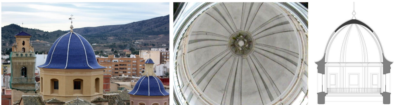
Figura 3. Cúpula de crucero en la Iglesia de San Juan Bautista en Monóvar. Imagen izquierda. Vista exterior de la cúpula. Imagen central. Vista interior de la cúpula. Imagen derecha. Sección donde se identifica la diferencia de perfiles interior y exterior en la cúpula peraltada. (Fuente propia).
