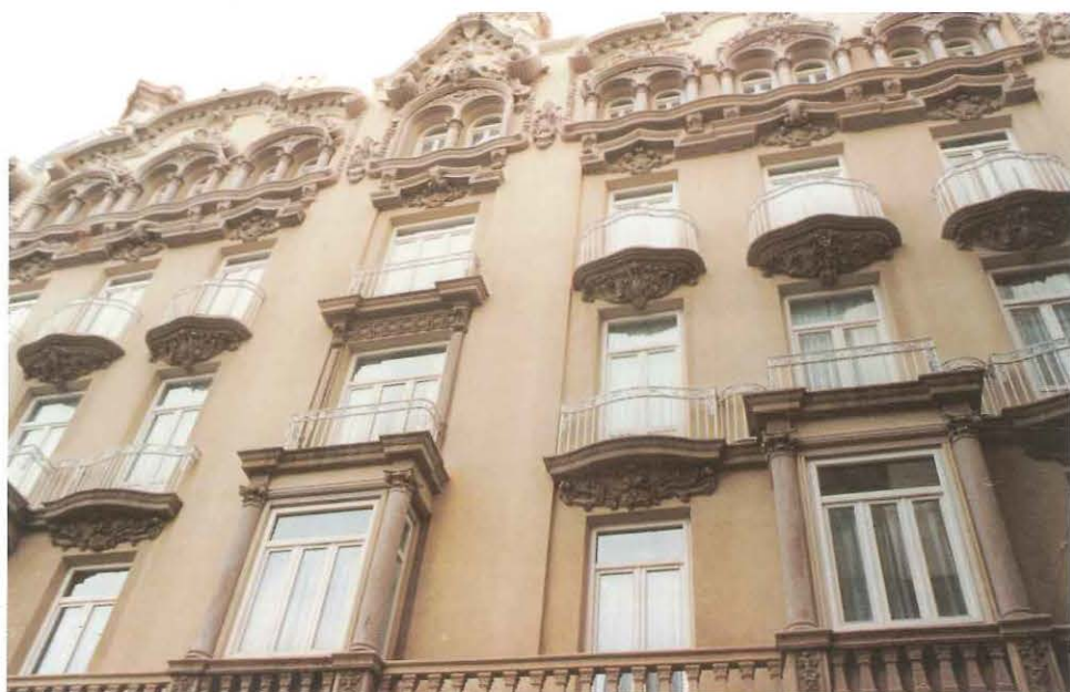
Gran Hotel. Fachada a la calle Marqués de Molins.
