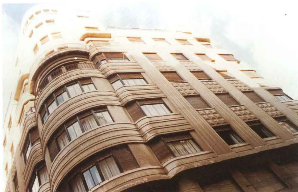
Edificio Legorburo. Calle Mayor esquina calle Marqués de Molins.
