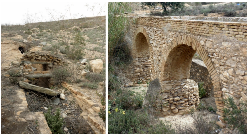
Figura 5. Decantador previo al puente de dos arcos y puente de dos arcos de la Casa de Girón.
