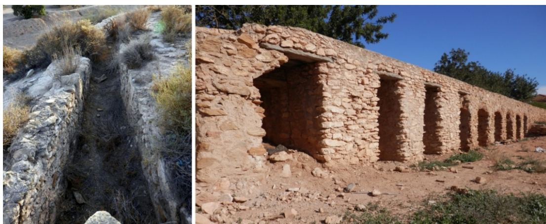
Figura 3. Acequia descubierta a la entrada de los cubos del molino y puente-acueducto de El Estrecho.
