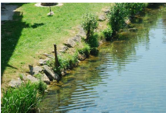
En la fotografía de detalle se observa la protección de escollera en la base del talud del río. La ampliación se realiza únicamente en la margen derecha.
