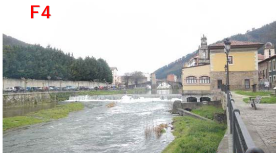
F4 Rebaje de cota de coronación azud situado en PK 30+380, muro en MI
