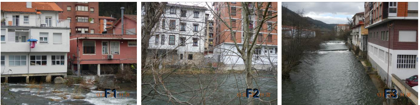
Viviendas junto al cauce en margen izquierda
