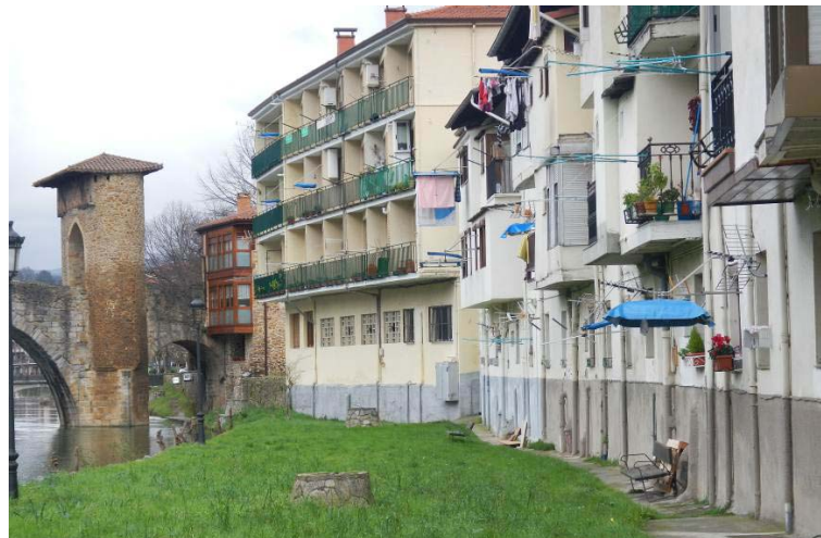
Vista desde aguas arriba del Puente de La Muza en Balmaseda y afección a viviendas en margen derecha
