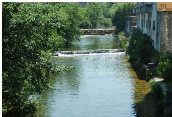
Azud a demoler en la Fase 2
