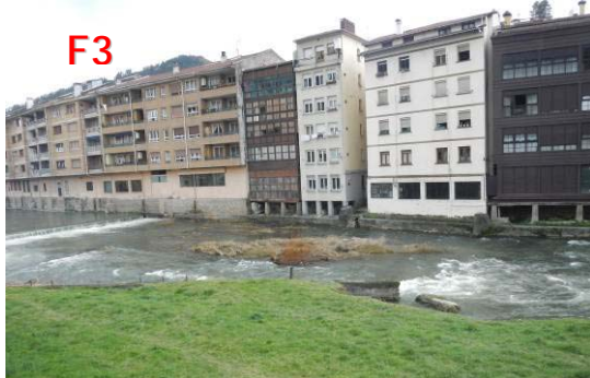
F3 Demolición de azud, acondicionamiento cauce aguas bajas y regularización del fondo
