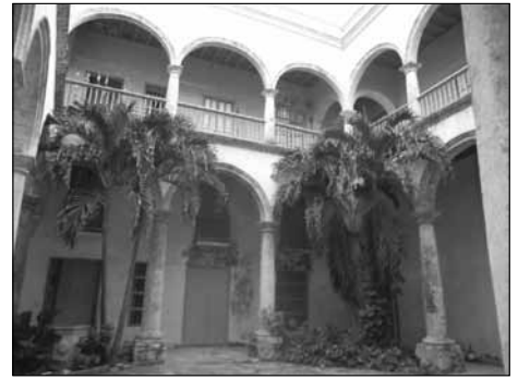
Patio de la casa del conde de Jaruco. La Habana, Cuba. Fotografía de Adriana Méndez Rodenas.
