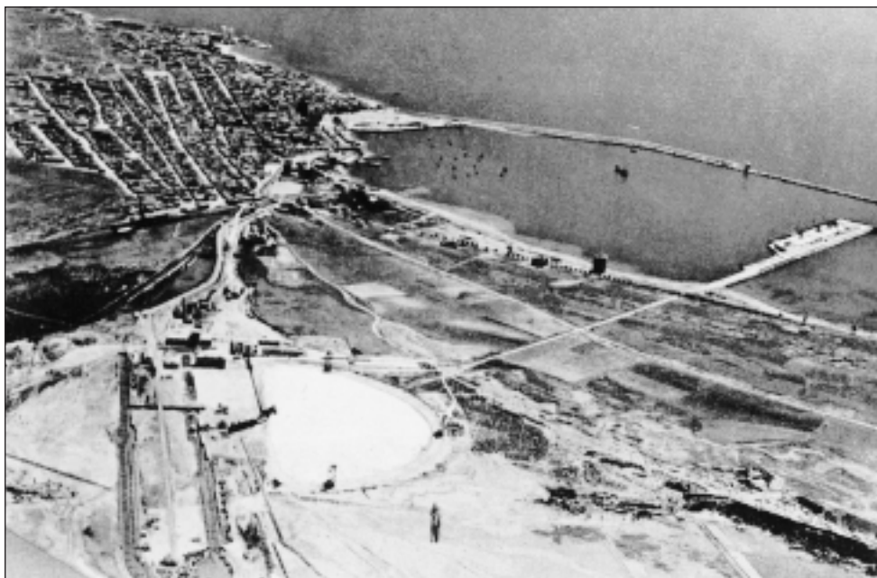
FIGURA 10. Imagen general de las actuales instalaciones del puerto de Torrevieja, finalizado en 1963, en la que se ve el Dique de Poniente acabado. En la actualidad alberga el muelle de la sal, conectado con la explotación salinera.
