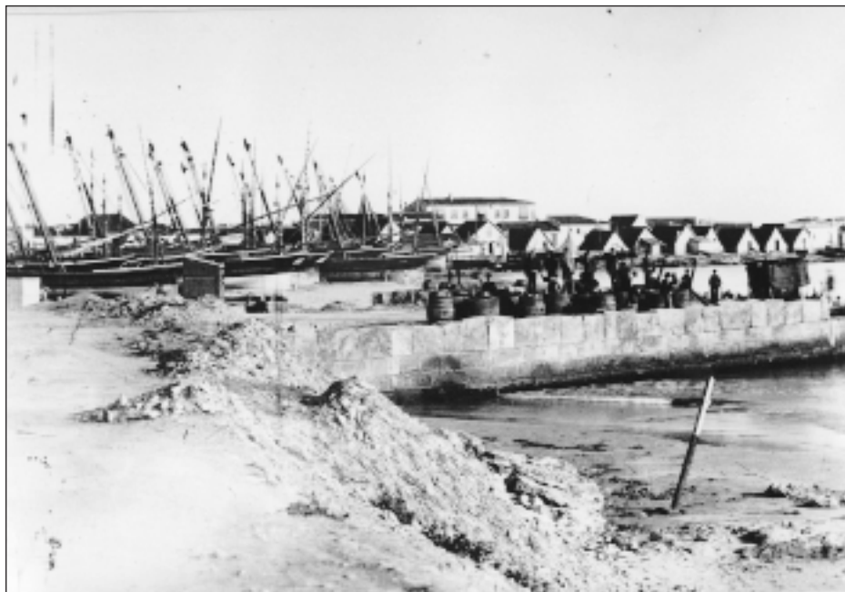
FIGURA 6. Detalle del muelle de sillería, primer intento de crear unas instalaciones portuarias adecuadas en la costa de Torrevieja.
