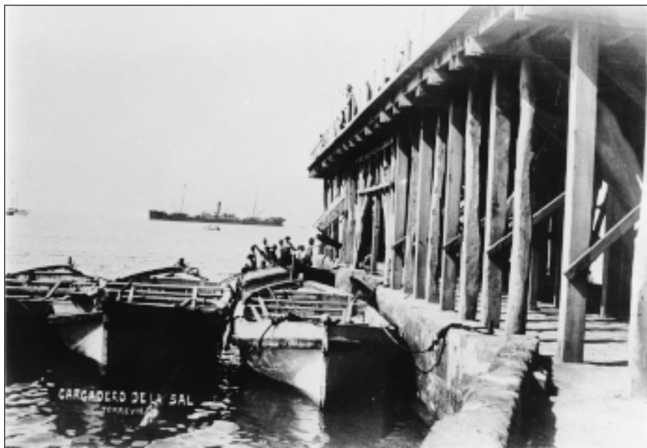
FIGURA 8. Detalle del embarcadero de sal, que consistía en un robusto andamiaje de madera, apoyado en una base de sillería. En él cargaban, hasta hace poco, las barcazas que llevaban la sal hasta los buques.
