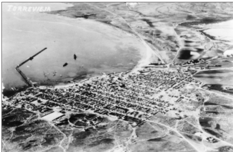
FIGURA 9. Vista aérea de la población de Torrevieja. Se observa la construcción del dique de Levante, cuyas obras se iniciaron en 1915. Su puesta en marcha supuso un avance importante en la dotación de infraestructura portuaria en la costa de Torrevieja.
