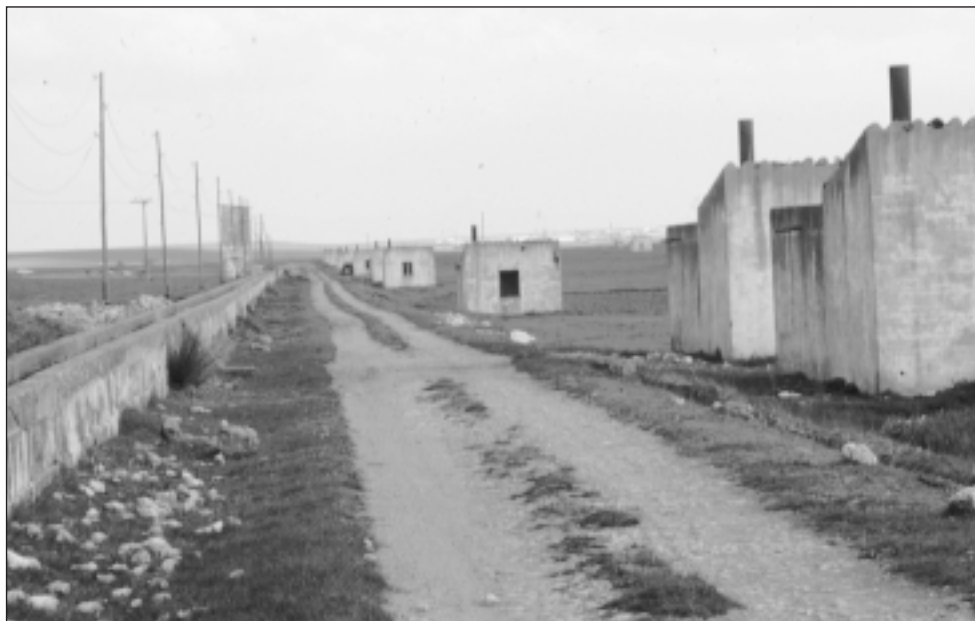
FIGURA 16. Torreperales: abandono actual de caceras y casetas.
