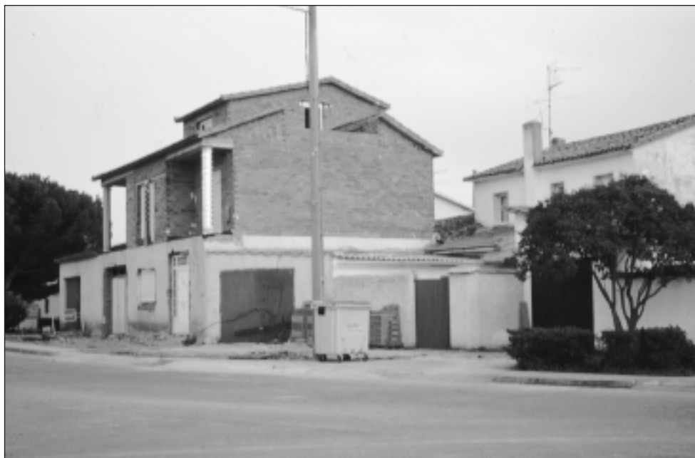
FIGURA 18. Nuevo Naharros: transformación de las iniciales casas rurales.
