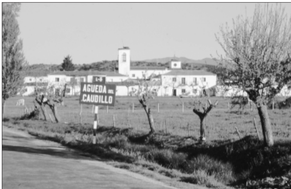
FIGURA 17. Águeda del Caudillo: permanencia del carácter inicial.
