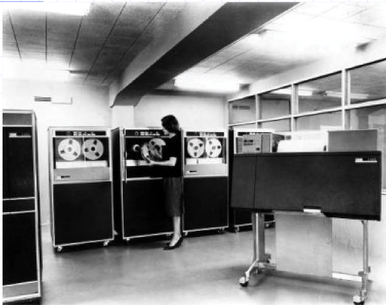
Ilustración 2.6 - IRM 1401 instalados en Galerías Preciados, Madrid 1962
