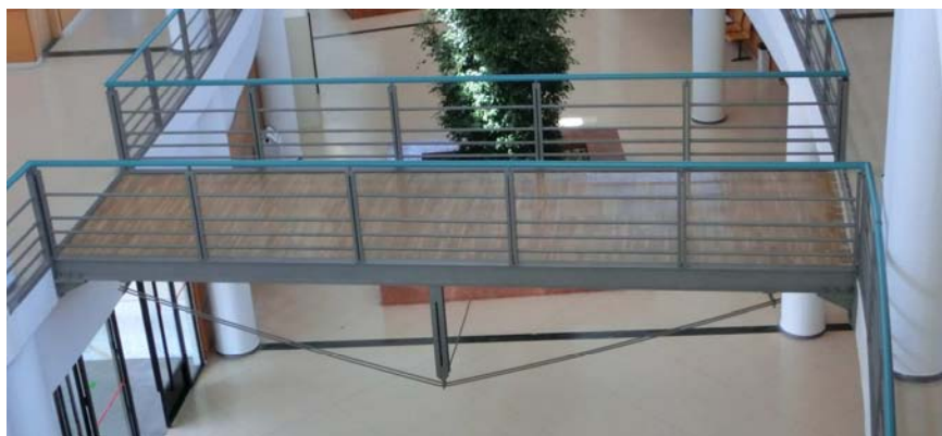
Figura 4.7 Pasarela dentro de un edificio de la Universidad de Alicante.
