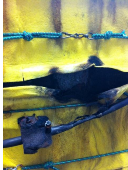
Detalle de deterioro de conexión entre fieltro de grafito y cable (tornillo y arandela)
