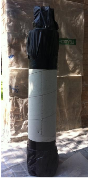
Preparada para proyección de pasta de grafito-cemento
