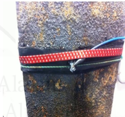
Detalle de conexión con fieltro de grafito y 20 cm. de malla Ti-RuO 2
