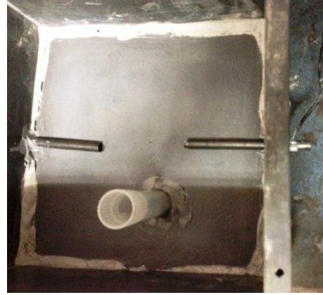
Detalle de electrodos de grafito para conexión anódica
