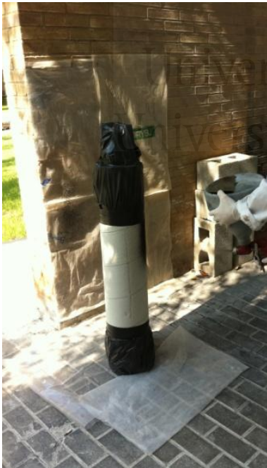
Preparada para proyección de pasta de grafito-cemento
