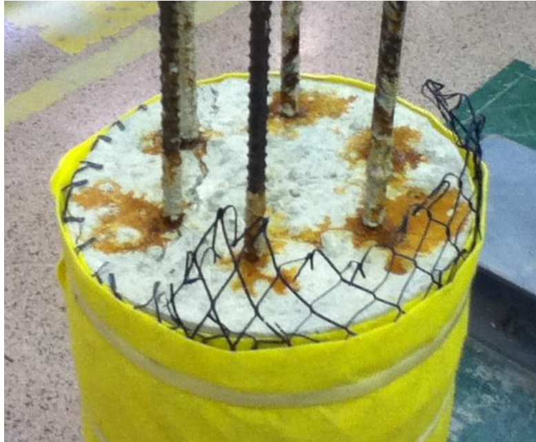
Fotografía 1.7. Detalle de montaje del sistema anódico con malla de Ti-RuO 2
