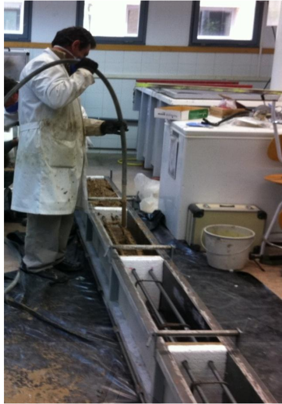
Fotografía 3.6. Disposición de los encofrados para recibir el hormigón
