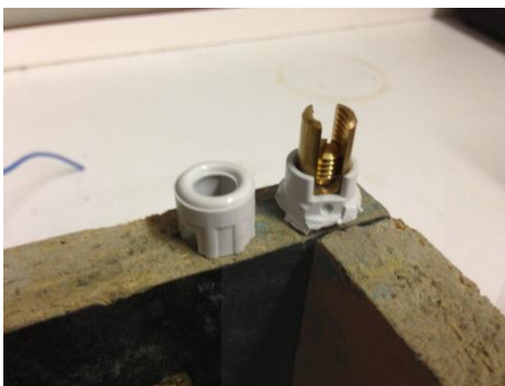
Detalle de elemento de conexión catódica
