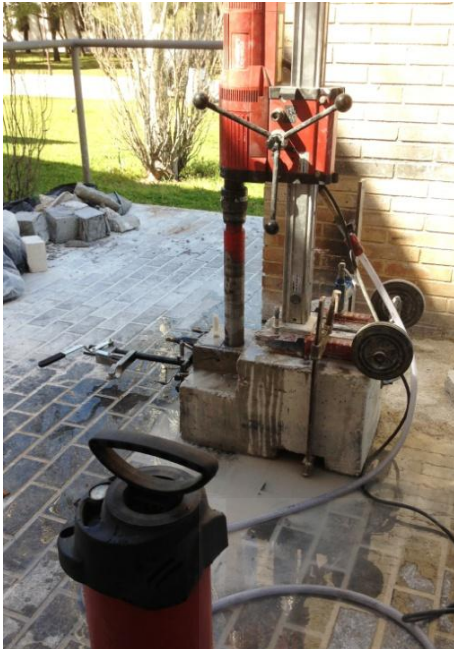
Extracción de testigo para análisis de contenido de Cl -
