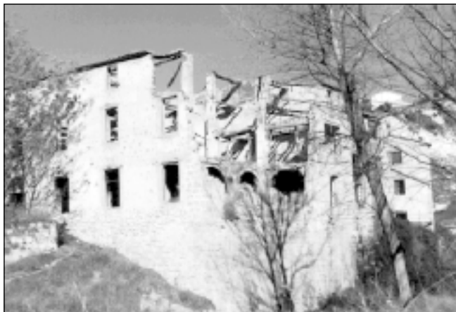
Foto 5. Fábrica en ruinas en la partida de la Riba. En la parte inferior del edificio se observan las bóvedas de gravedad. En los molinos papeleros esta planta se solía destinar a las pilas y a las tinas. En la superior se ubicaban las dependencias dedicadas al secado de papel. FUENTE: Archivo particular.
