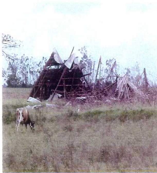
Foto 1: Condiciones de las construcciones rurales después del paso del ciclón.
