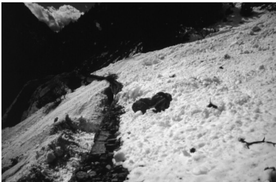
FOTO 4. Aspecto del alud por encima de una de las viseras antialudes, cuya galería puede apreciarse en la parte centro-izquierda de la foto. La carretera A-2606 pasa por debajo.
