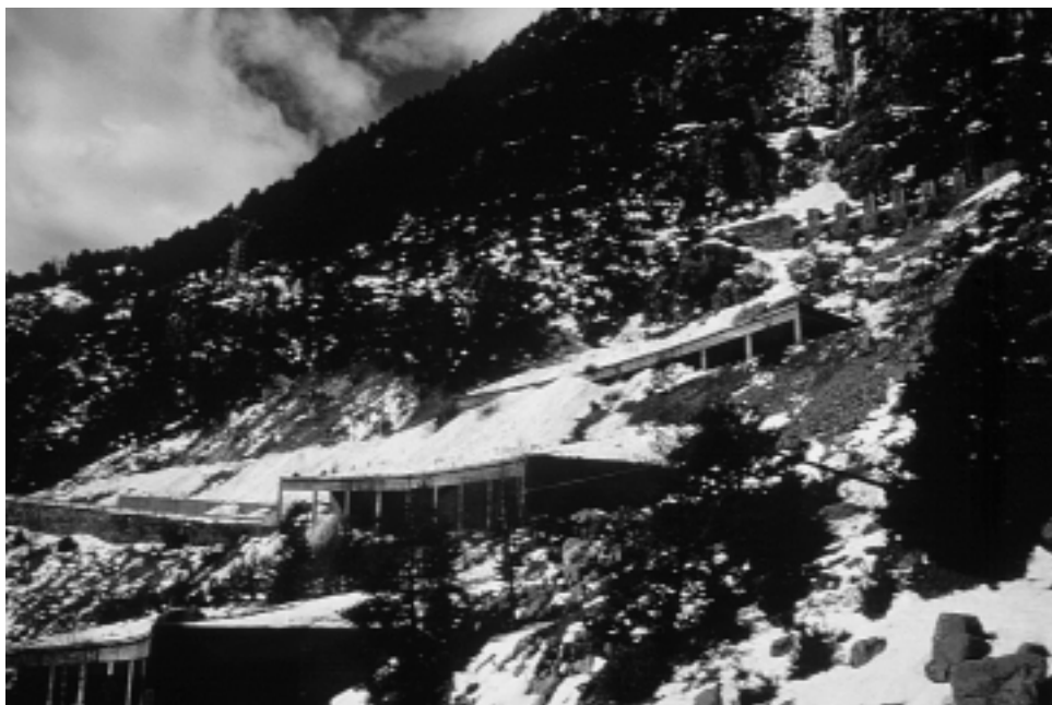
FOTO 1. Vista general de las obras de protección existentes en la canal del alud de Peña Gabarda: tres viseras de derivación escalonadas, bajo las cuales pasa la carretera A2606, y dos muros huecos, en la parte superior de la foto. La trayectoria del alud está marcada por la disposición de estas estructuras. Se ven también varias lazadas de la carretera, que se encuentra sometida a un riesgo evidente.
