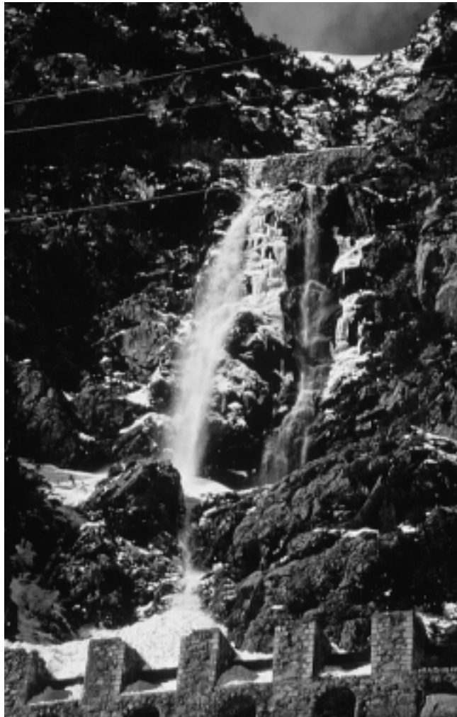
FOTO 2. Detalle de los dos muros huecos de frenado del alud. Obsérvese en el inferior que se halla colmatado por la nieve caída, por lo que posteriores aludes no encontrarían ningún freno. En el momento de tomar la foto, caía un nuevo alud de pequeño volumen, que en ese momento salvaba el salto casi vertical existente entre los dos muros. Véase la caída de nieve a la izquierda de la cascada de agua.
