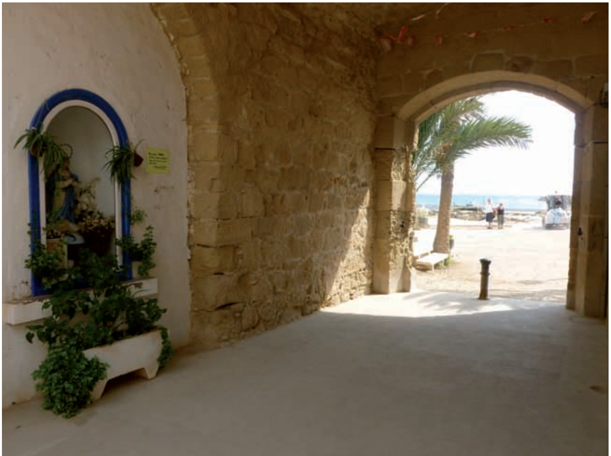
Detalle de la puerta de San Rafael desde el interior del complejo amurallado de Nueva Tabarca
