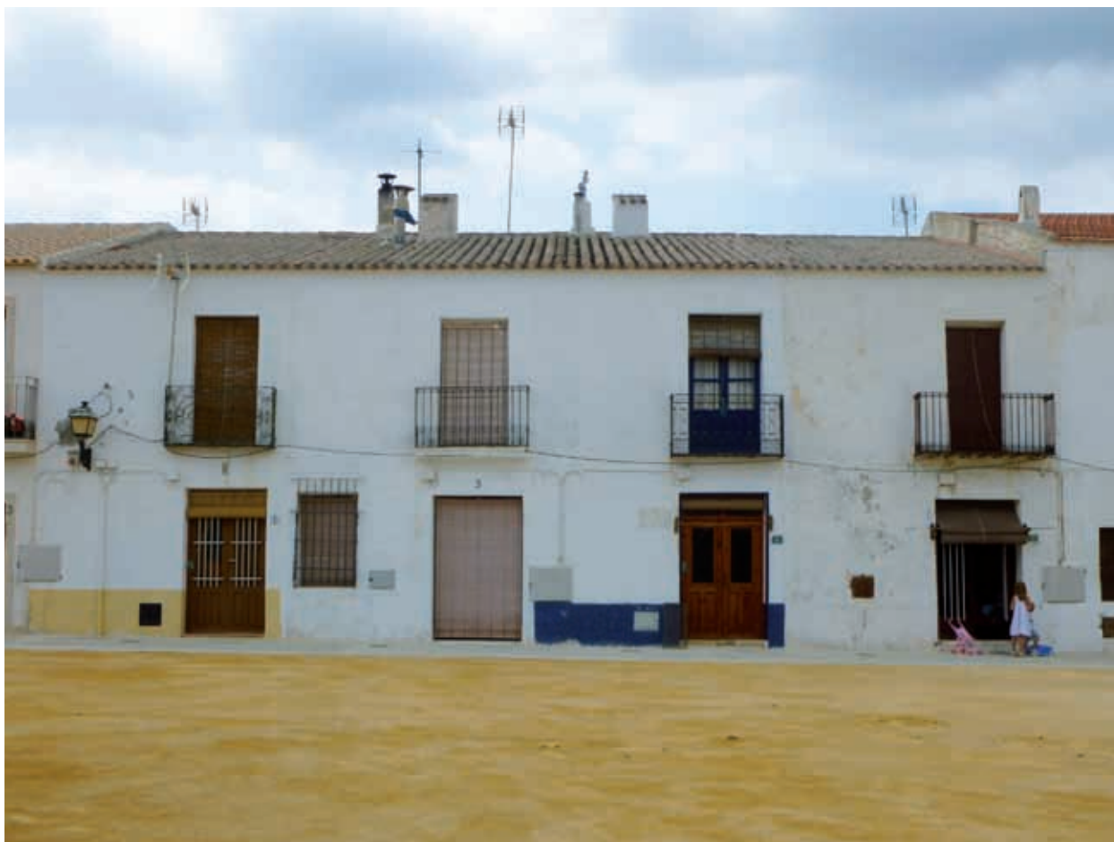
Viviendas en el frente sur de la Plaza Grande de Nueva Tabarca, donde se puede apreciar la homogeneidad de las casas primitivas, caracterizada por la existencia de dos vanos en la fachada (puerta y balcón)
