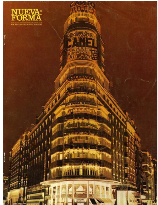
Fig. 5.- Edificio Capitol: “expresionismo y comunicación”.
