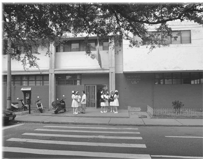
Fachada antigua Facultad de Enfermería
