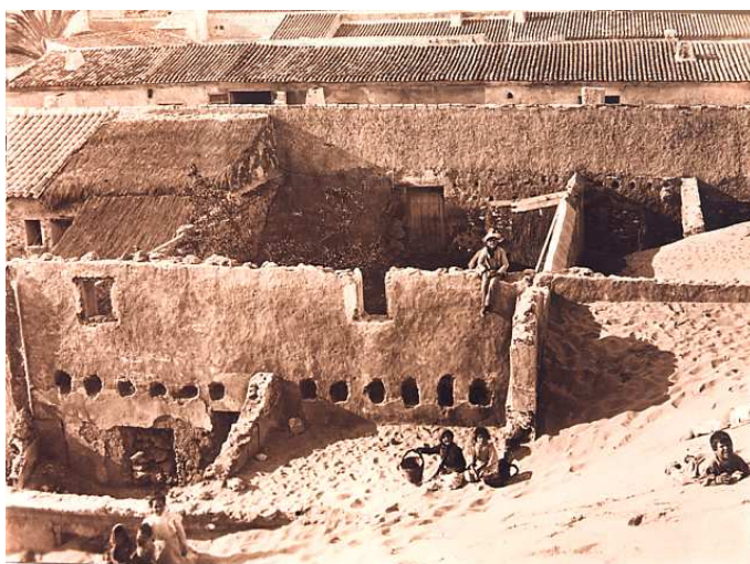
Casas con los techos hundidos por el peso de las arenas. Año 1901.
