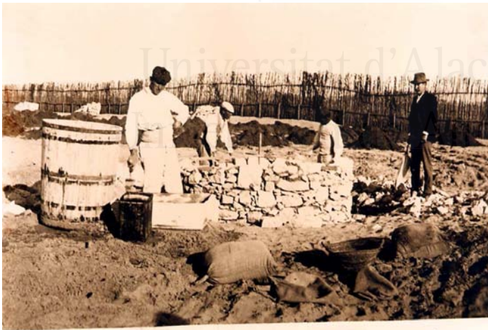
Construcción de un pozo para riego del vivero. Año. 1903
