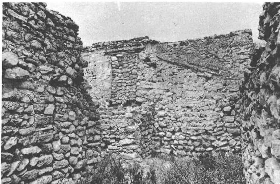
Fig. 5. —Interior de la casa 7. Són apreciables les tapiades i les seves dimensions i la finestra cegada de la casa 8.
