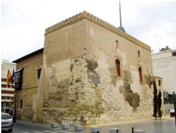
Fig. 2. Fachadas Norte y Oeste, año 2010.
