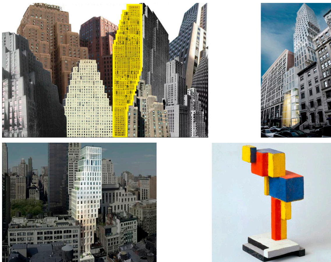
Figura 3. Arriba. Izquierda: “postal” que muestra la intervención junto a otros edificios. Derecha: el primer volumen “estrujado” por la estrechez del solar y las ventanas en los vuelos. Abajo. Izquierda: La Torre abalanzándose sobre la vecina. Derecha. Vantongerloo, G. (1918), Escultura. Fuentes: Web de OMA; Dezeen; Pinterest.
