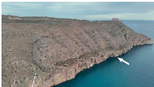
FIGURA 3. Extremo oriental del acantilado del Morro de Toix imagen tomada desde dron. La línea blanca discontinua coincide con la de la Fig. 2. La flecha marca la posición aproximada del sumidero de Toix, que se encuentra a 8 m de profundidad. La cornisa del acantilado está mayormente extraplomada sobre el mar.
