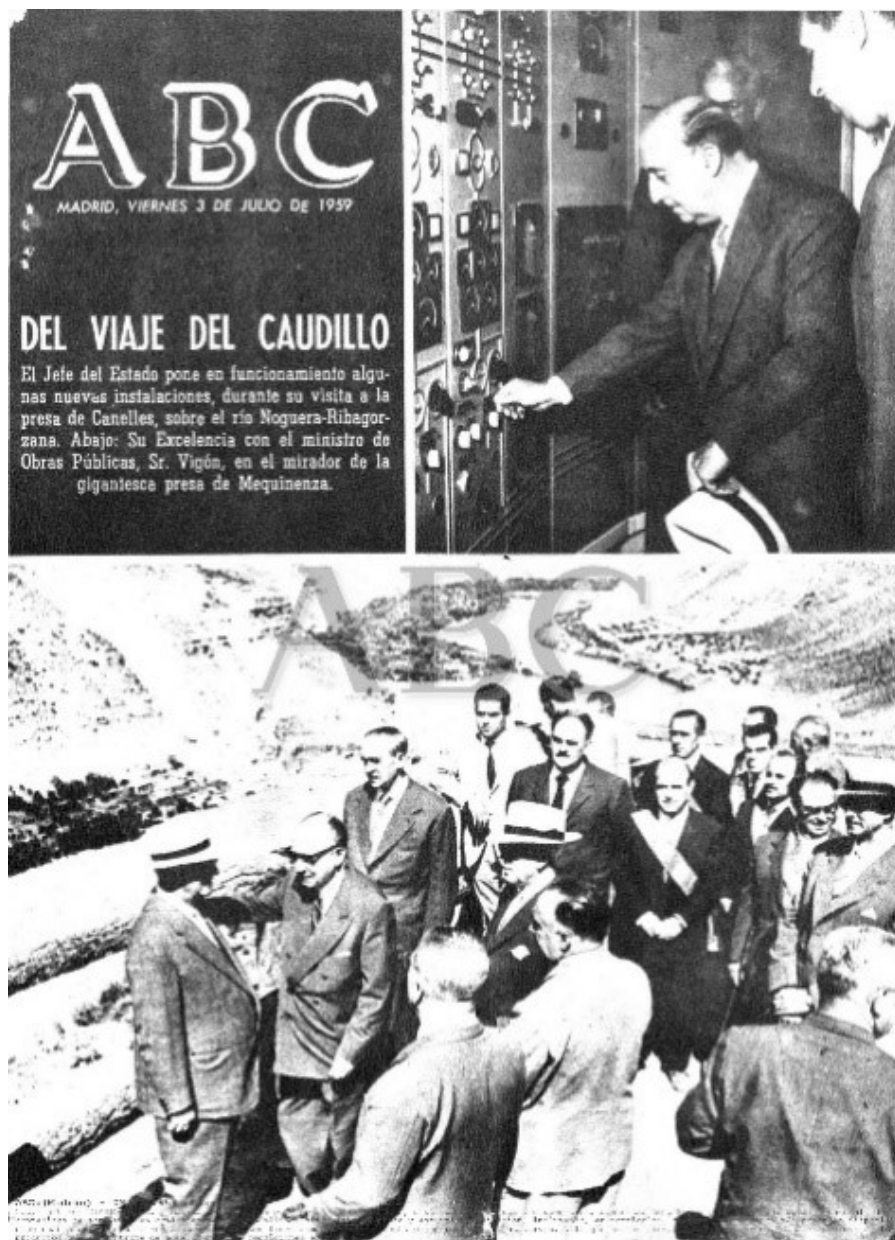
Primera página ABC Madrid 3.7.1959, p. 1: «El Jefe del Estado pone en funcionamiento algunas nuevas instalaciones, durante su visita a la presa de Canelles, sobre el río Noguera-Ribagorzana. Abajo: Su Excelencia con el ministro de Obras Públicas, Sr. Vigón, en el mirador de la gigantesca presa de Mequinenza.»
