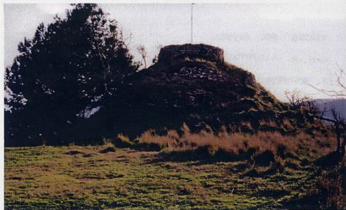
Panoràmica del conjunt abans de començar la intervenció. Fons documental del SPAL de la Diputació de Barcelona. Autor: Raquel Lacuesta. 1997.
