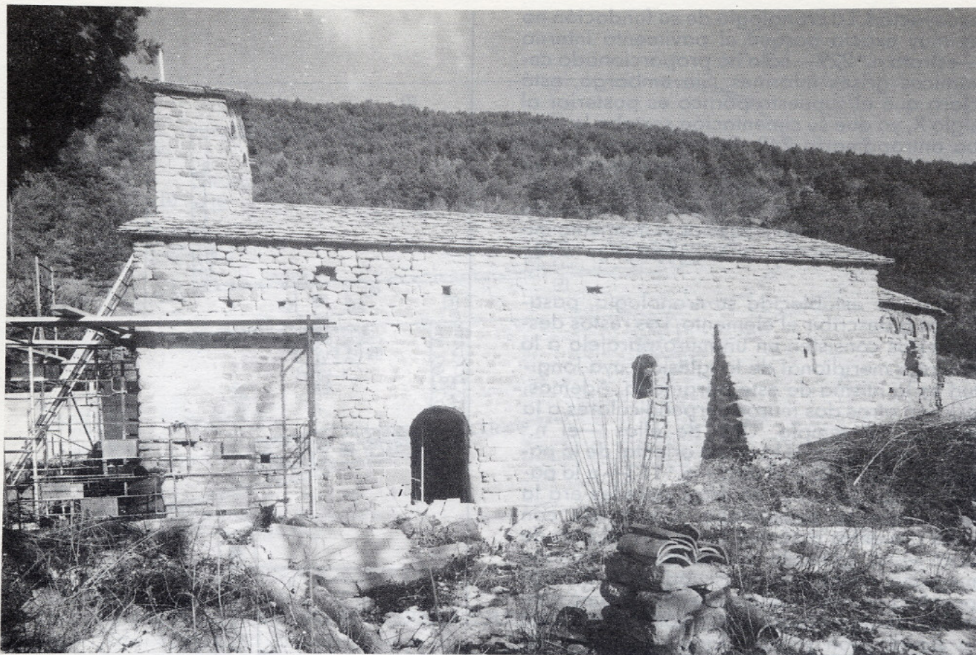
Lámina I.—A) Vista desde el sur de la iglesia de Sant Vicenç de Rus, durante las actuales obras de restauración (enero 1987).
