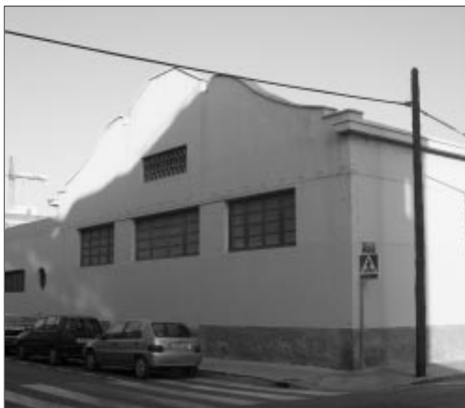
Fig. 16. Detall de la testera avitolada del magatzem nord-est.
