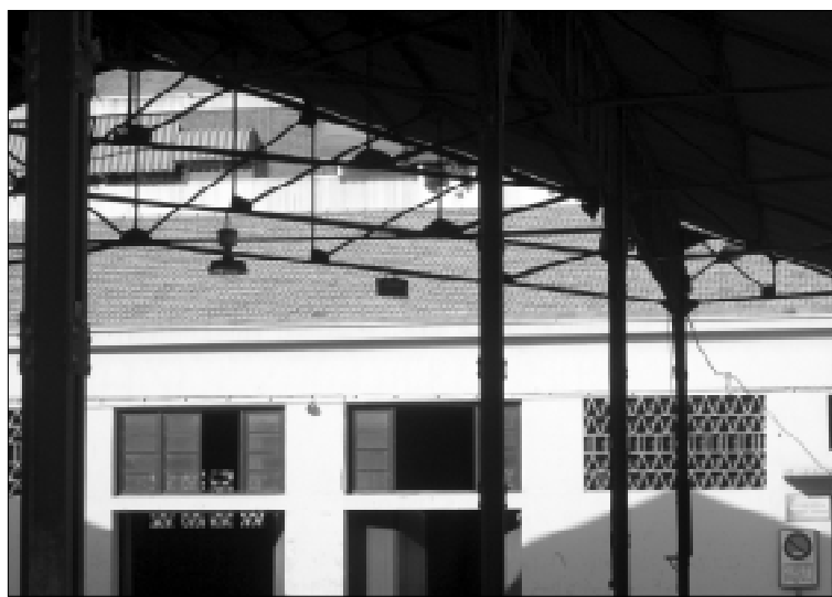
Fig. 15. Detall d'una armadura encavallada metàl·lica d'una nau i les portes i la gelosia ceràmica del magatzem nord.
