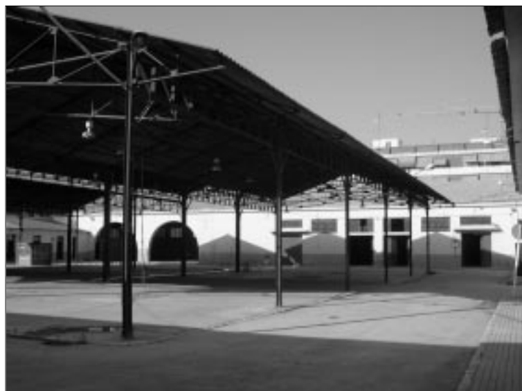
Fig. 5. Vista del pati interior de la Llotja cap al nord: pavellons laterals, naus obertes i magatzems.
