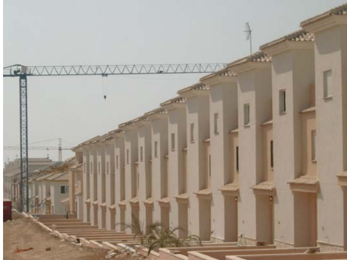
Imagen 7. Urbanización de adosados en plena fase de construcción (Mazón).
