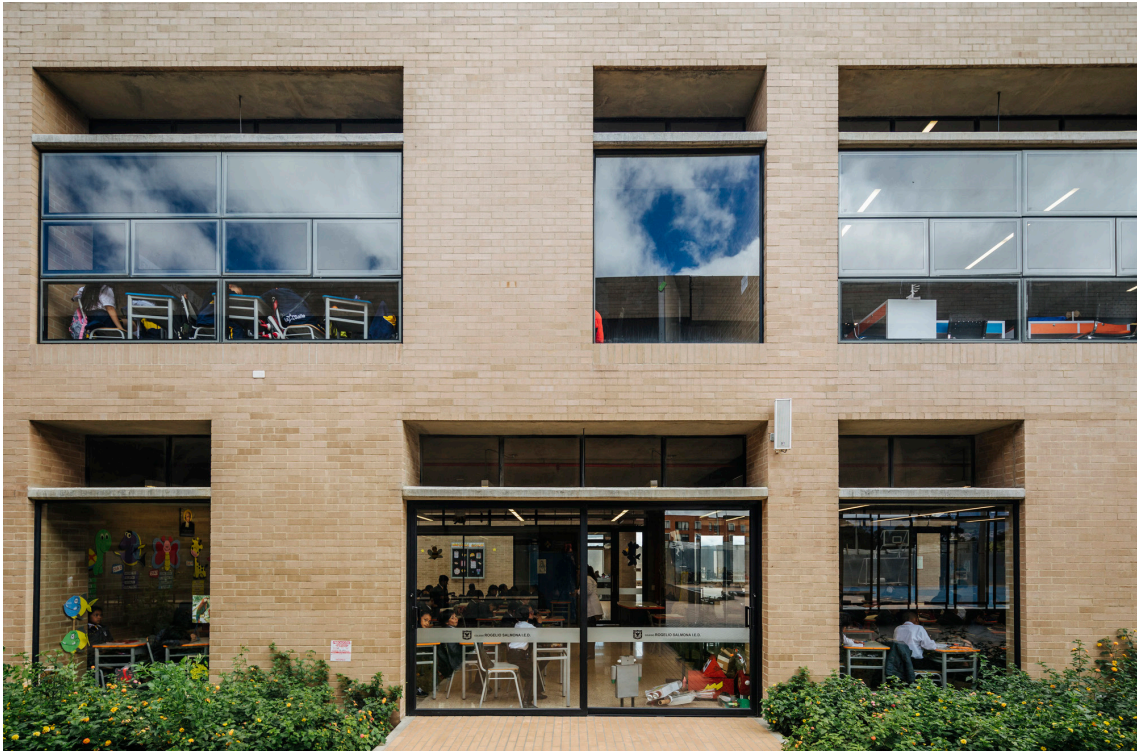
Fig. 6. Transparencias y continuidades visuales en el Colegio Rogelio Salmona, Bogotá. Arqs. Iván Forgioni y José Puentes, 2019. Foto: Mauricio Arango.
