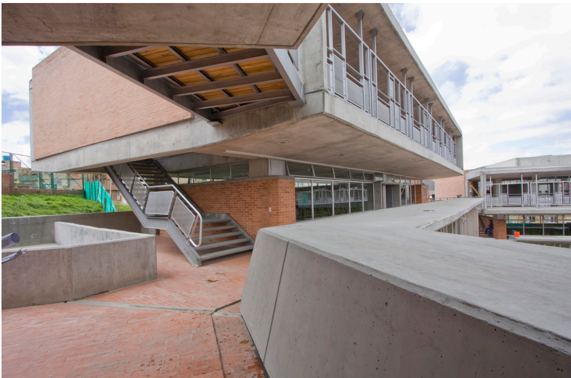
Fig. 7. Múltiples visuales hacia y desde el barrio circundante integran el colegio a la comunidad. Colegio Orlando Fals Borda. Arq. Leonardo Álvarez, 2008. Foto: Secretaría de Educación del Distrito de Bogotá.
