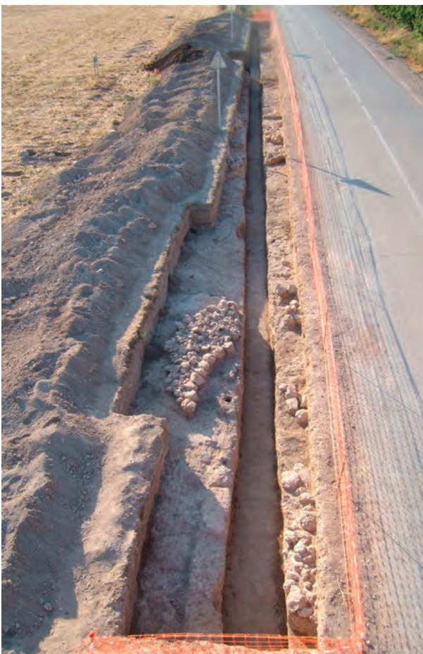
Fig. 2 Vista del área de excavación.
