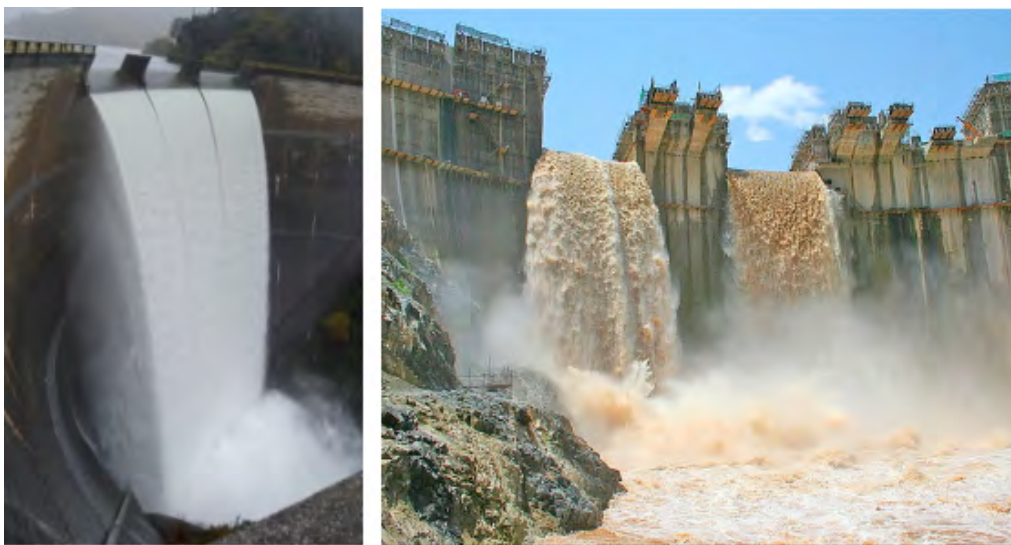
Figura 1. (a) Aliviadero de vertido libre, Presa de Eume, España (b) Sobrevertido durante la construcción, Presa Tekeze, Etiopía (Snook, 2007).
